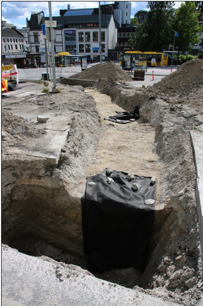
Figur 14. Grøften 1075. Fra miljøgropen SG 1 til sjakten fra 2008. Sett mot SV. Cf53309_NIKU_616152.
