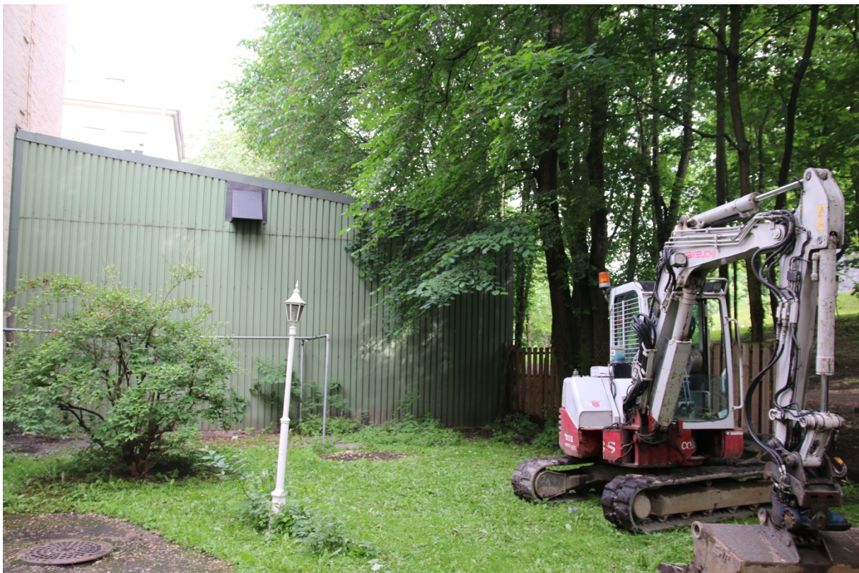
Figur 1: Tiltaksområdet før graving. Sett mot V. Foto-nr: Cf53299_NIKU_0003
