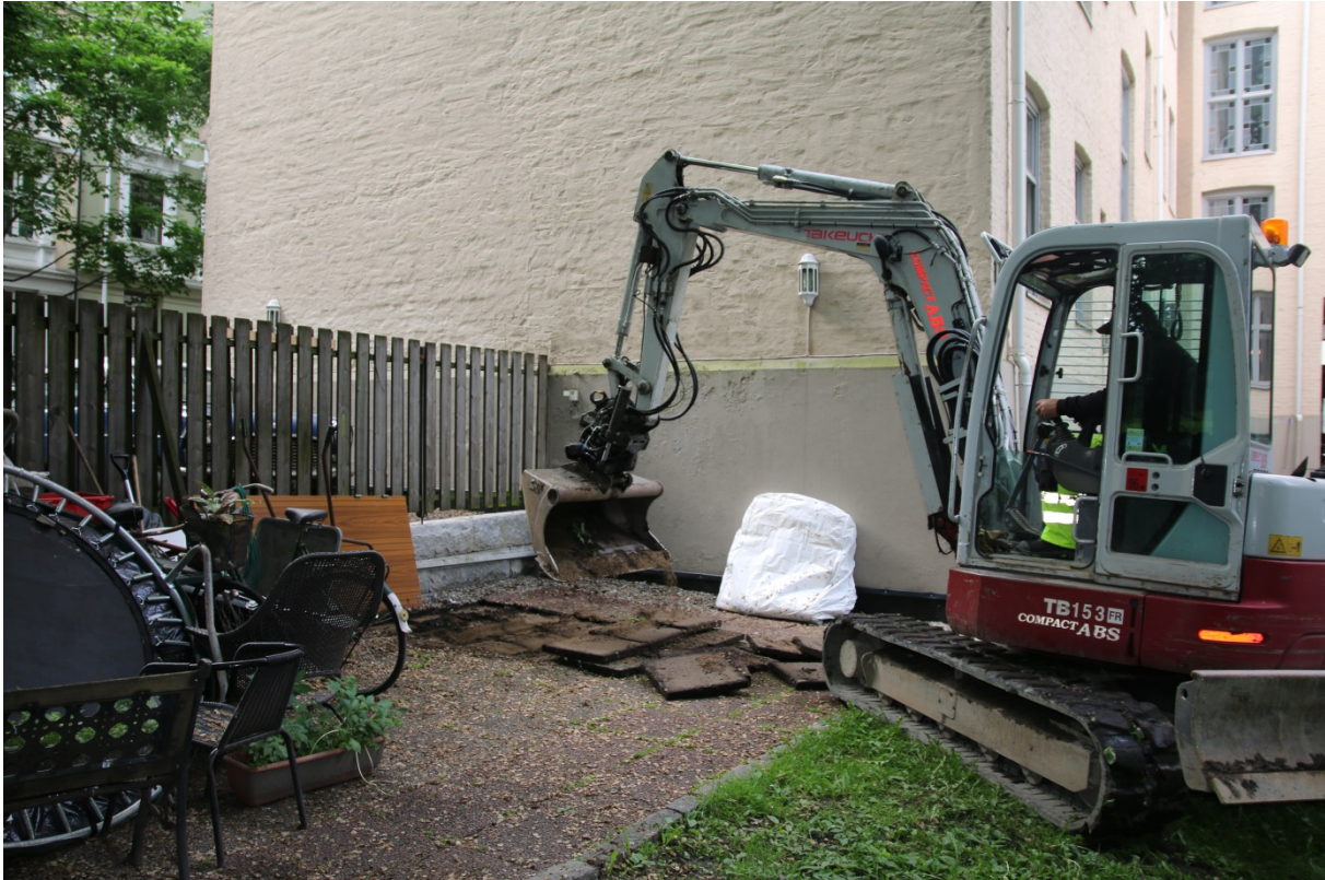
Figur 2: Arbeidsbilde graving av østre grøft. Sett mot SØ. Foto-nr: Cf53299_NIKU_0005
