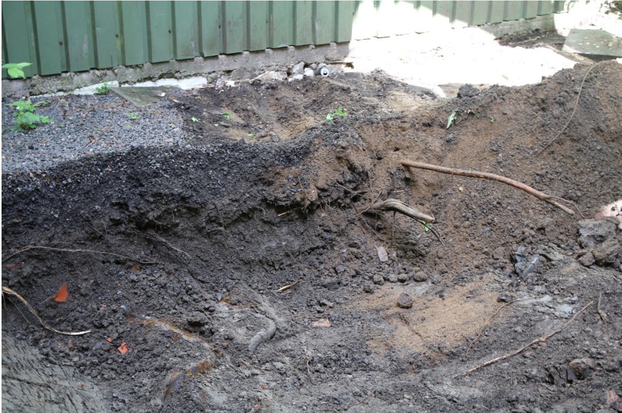
Figur 5: Vestre grøft med nedgravd oljetank. Sett mot V. Foto-nr: Cf53299_NIKU_0021
