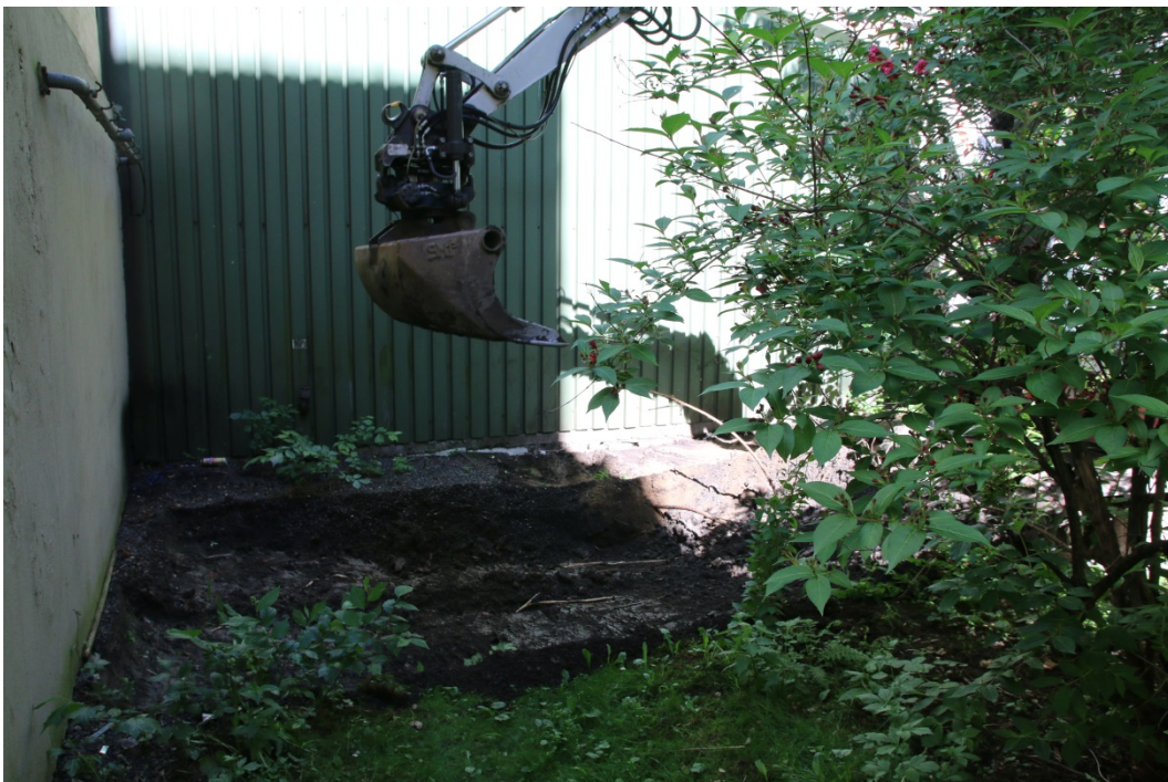
Figur 4: Graving av vestre grøft. Sett mot V. Foto-nr: Cf53299_NIKU_0018
