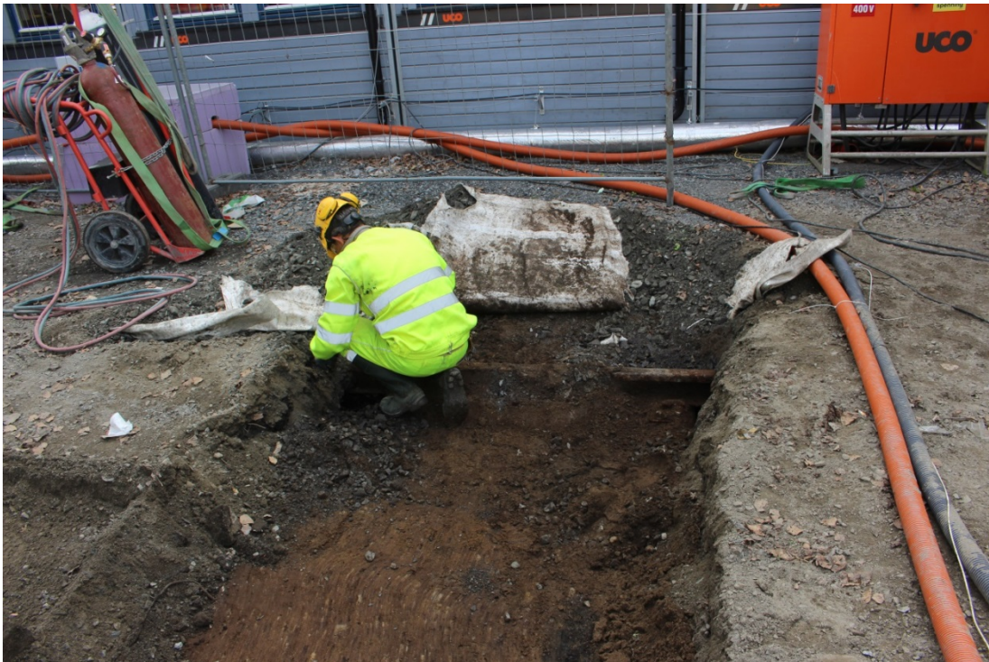
Figur 2: Jernbanespor kuttes med skjærebrenner. Sett mot øst. Foto-nr: Cf53294_NIKU_04
