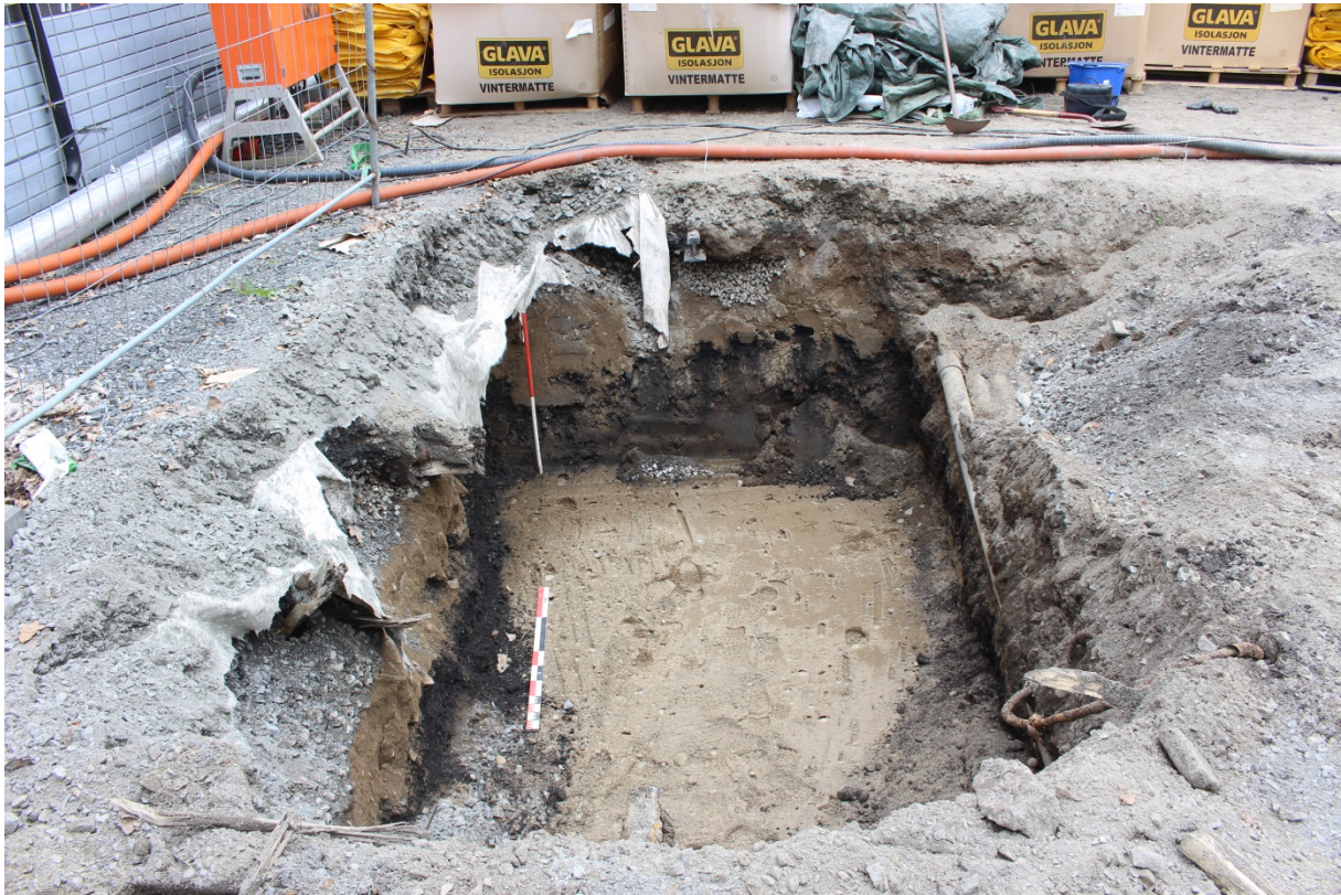
Figur 4: Ferdig gravd grøft klar for nedsetting av avløpstank. Sett mot sør. Foto-nr: Cf53294_NIKU_10
