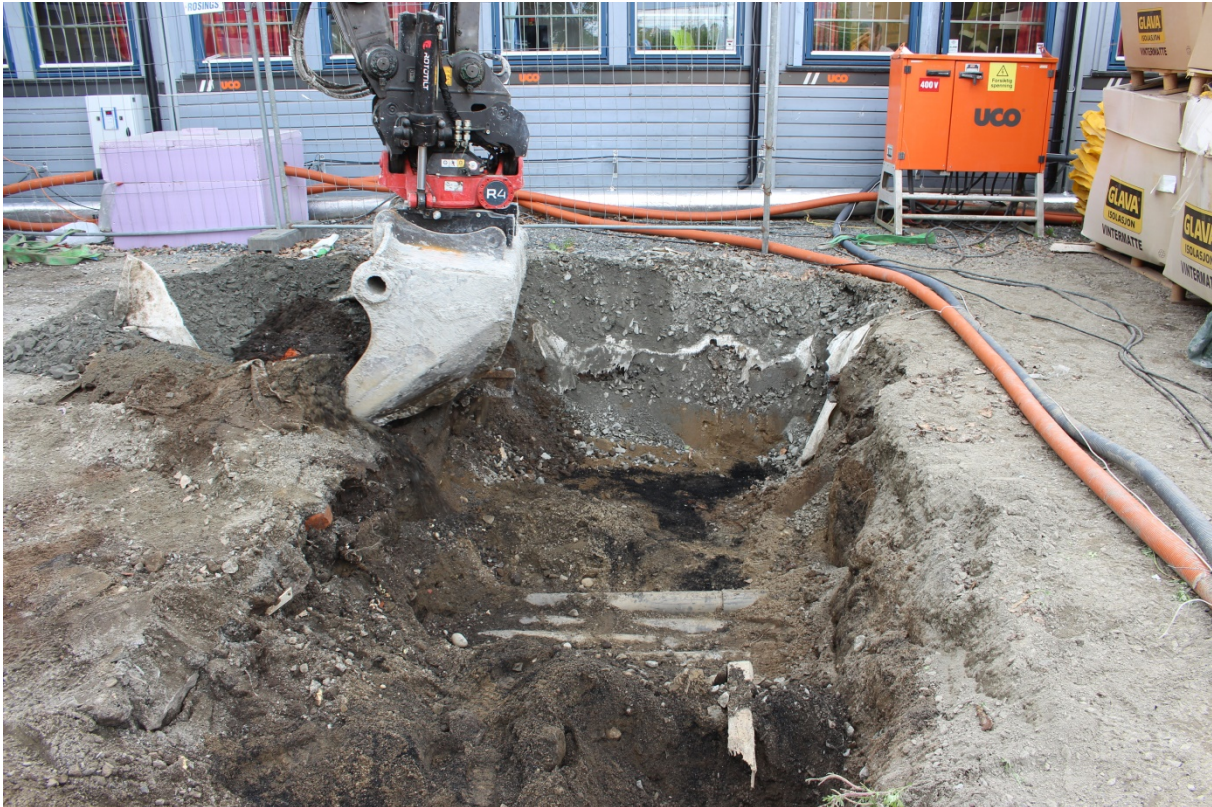
Figur 3: Det ble påtruffet kabler som førte til at grøften måtte graves N-S i stedet for Ø-V. Sett mot øst. Foto-nr: Cf53294_NIKU_06
