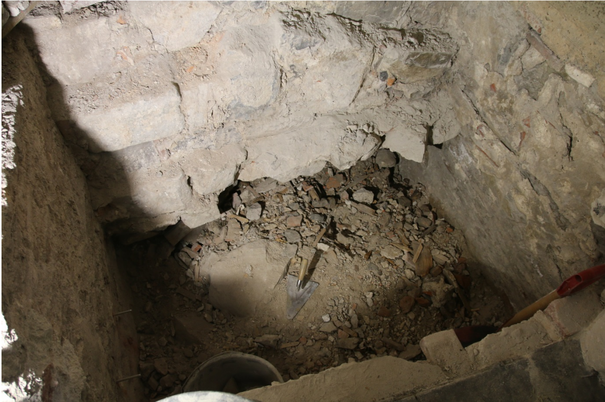
Figur 2: Arbeidsbilde, grop under trappa i Blåtårnet. Sett mot nordvest. Foto-nr: Cf53291_NIKU_0010
