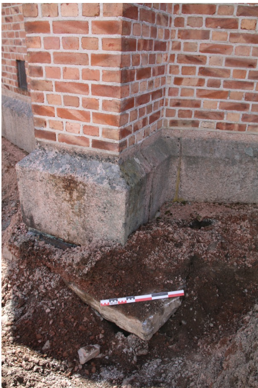
Figur 6: Fundamenteringsstein som stakk ut fra kirkemuren, østre grøft. Sett mot sørvest. Foto-nr: Cf53289_NIKU_0019
