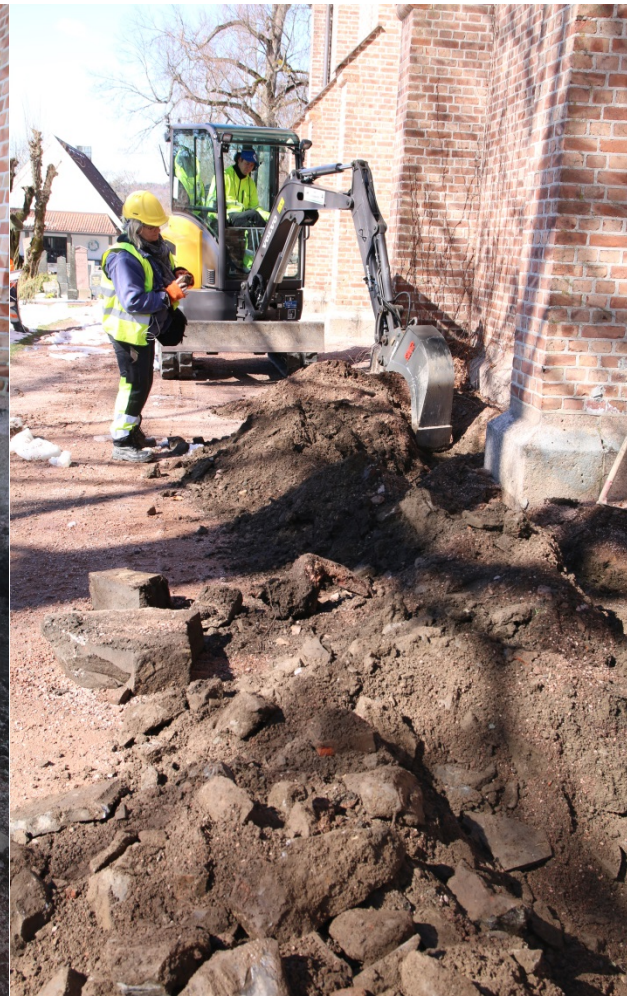
Figur 2: Arbeidsbilde graving av grøft på sørsiden av kirken. Reidunn Aasheim fra Akershus fylkeskommune fotograferte. Svært mye stein ble påtruffet i østre del av grøfta. Sett mot vest. Foto-nr: Cf53289_NIKU_0015
