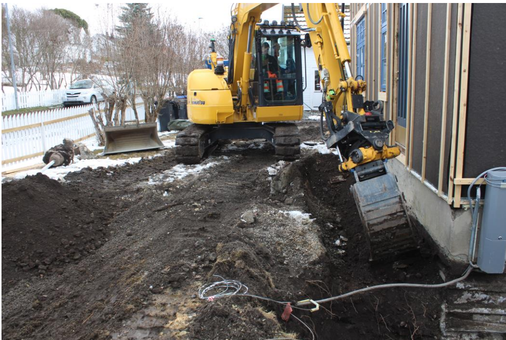
Figur 3: Arbeidsbilde av gravemaskin som avdekker strømkabler, sett mot NNØ. Foto nr: Cf53290_NIKU_0038
