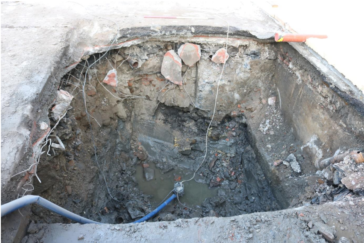
Figur 5: Pumping av vann i grop for oljeutskiller. Det lå moderne treverk i påfyllingsmasser mellom betongvegg og leire, sett mot N. Foto: Cf53280_NIKU_0022.
