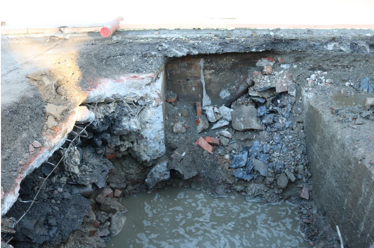
Figur 4: Fjerning av påfylte masser mellom betongvegger i grop for oljeutskiller, sett mot Ø. Foto: Cf53280_NIKU_0011.
