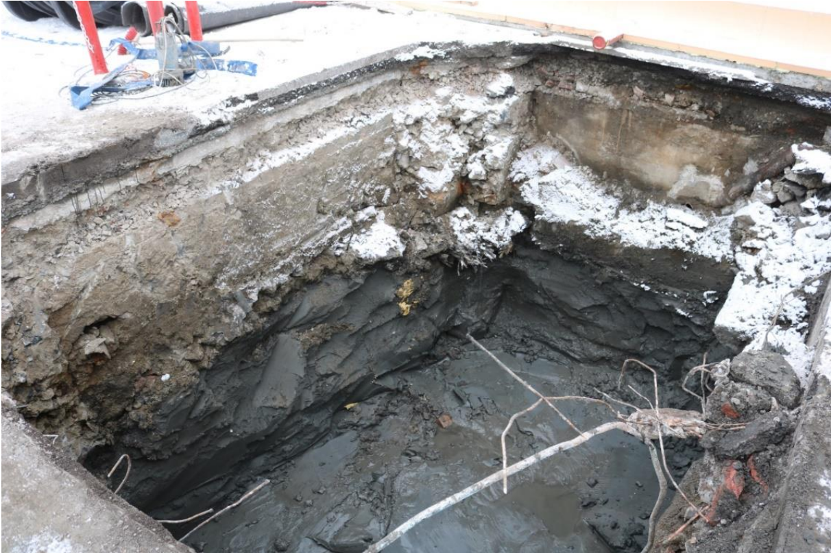
Figur 7: Ferdiggravd grop for oljeutskiller, sett mot NØ. Foto: Cf53280_NIKU_0063.
