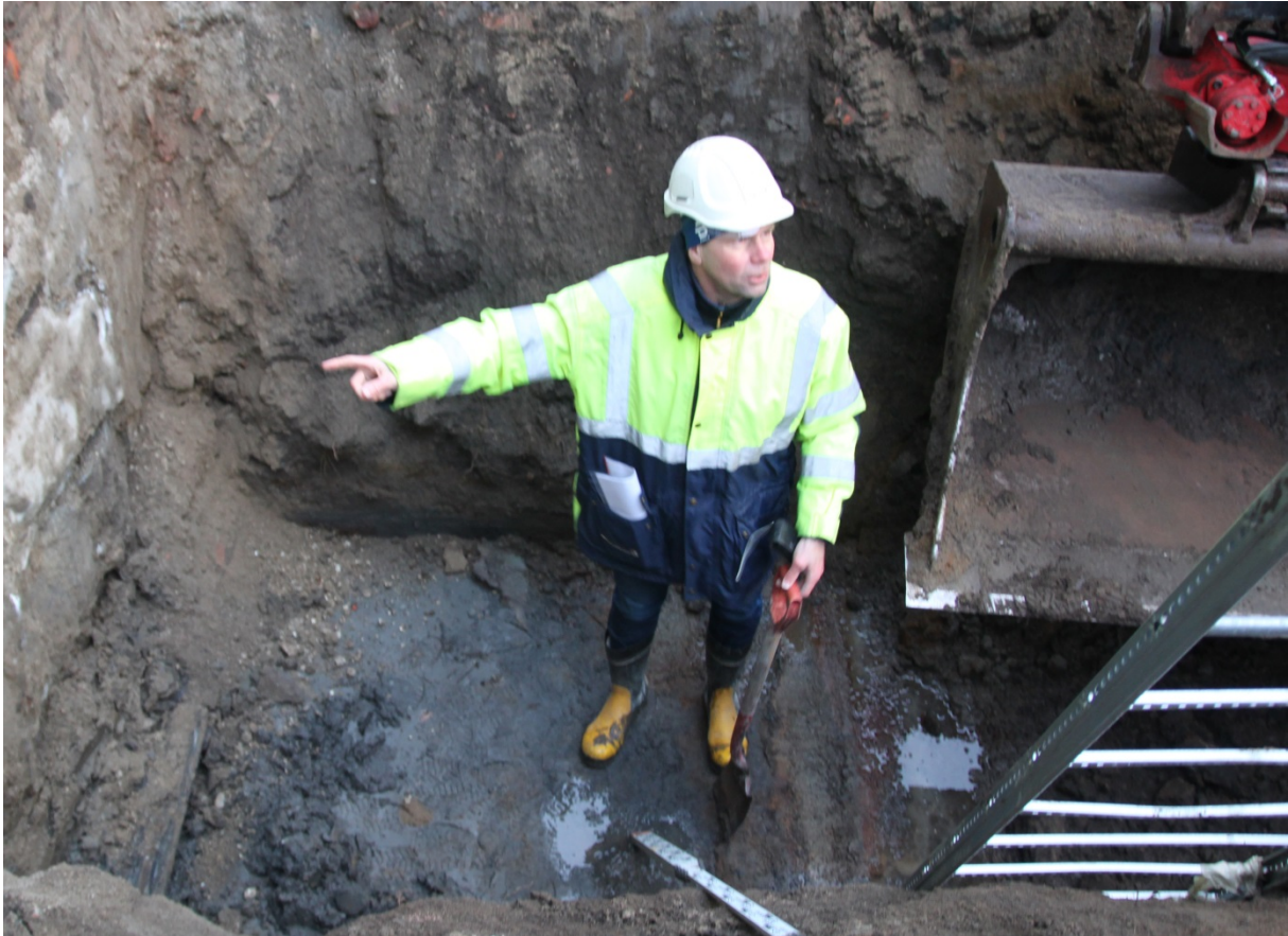
Figur 6 Geotekniker Jan Slungaard fra Sweco Norge AS, på bunnen av grop 1. Merk nord-sør-løpende sedimenter fra det gamle elveleiet i bunnen av gropen. Elveleiet består av sjikt av grus og sand, skåret ned i undergrunn av eldre marin leire. Bildet er tatt mot sør.
