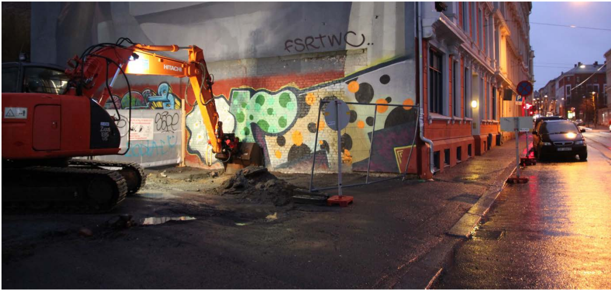
Figur 5 Graving av grop 1 mot veggen av Schweigaardsgate 48, sett mot nordøst. Ytterst til høyre sees krysset mot Grønlandsleiret, der det var kirkegård i middelalderen. Hjørnet av kirken vil fra denne vinkelen ha overlappet med hushjørnet til venstre i krysset.
