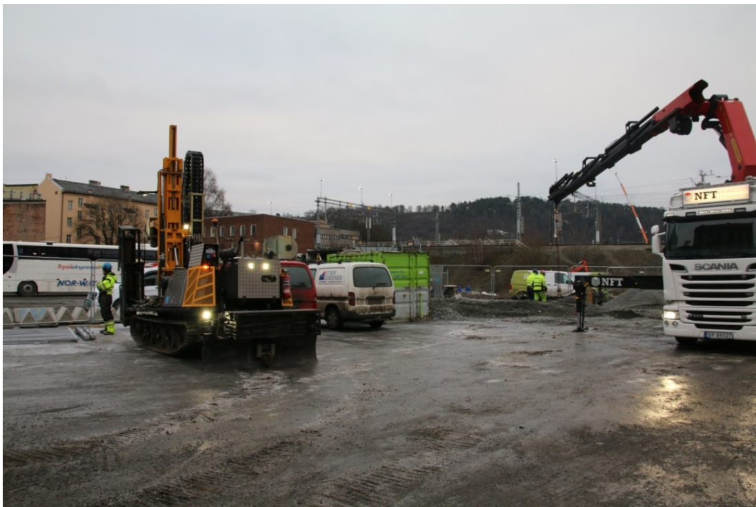
Figur 1: Oversikt før start, sett mot sørøst. Foto-nr: Cf 53277_NIKU_0002
