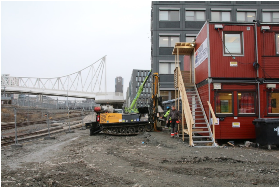
Figur 2: Arbeidsbilde, boring av BH15. Sett mot vest. Foto-nr: Cf 53277_NIKU_0053
