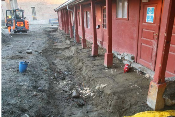
Dreneringsgrøften ferdiggravd. Takbærende søyler og den brune settesanden til det fjernete steinhellelaget vises til høyre →Ø Da60268_0018
