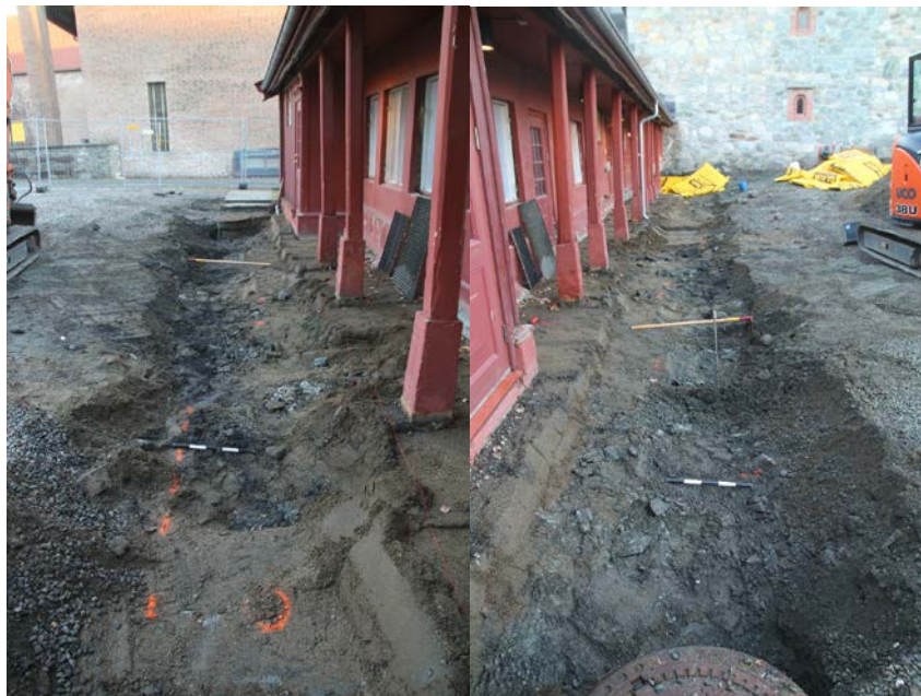
Den ferdiggravde dreneringsgrøftens østre halvdel. Venstre: Mørk brunt jord i bunn →Ø. Høyre: Kummen og fyllmassen i kumhullet →V. Da60268_0019 & Da60268_0020
