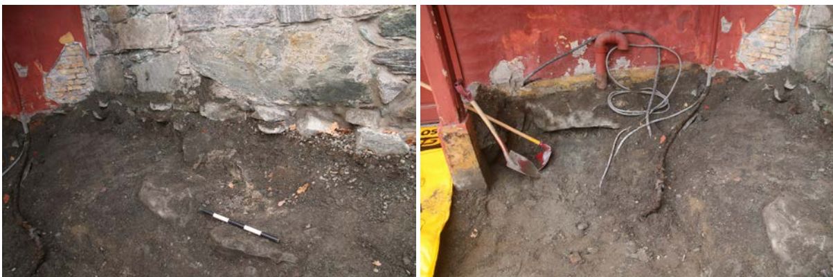
Venstre: Nærbilde av området med intakte kulturlag, steiner samt Feltartillerifløyens fundament →SV. Høyre: Nærbilde av kabelgrøften og den store steinen som stikker ut fra Artilleribyggets fundament →S. Da60268_0015 & Da60268_0016
