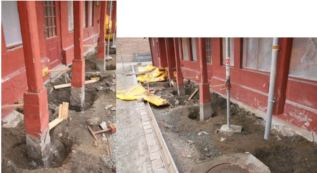
De ferdiggravde hullene rundt søylefundamentene → V og Ø. Da60268_0011 & Da60268_009
