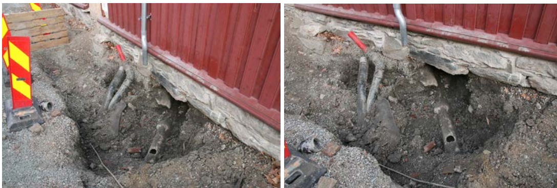
Det ferdiggravde hullet for trekkekummen →NV. Da60268_007 & Da60268_006
