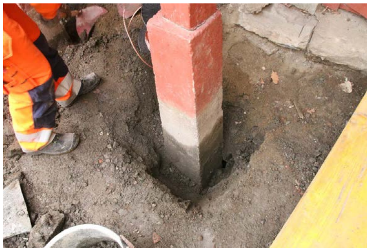
Nærbilde av et hull som ble gravd rundt et av søylefundamentene. Da60268_008.
