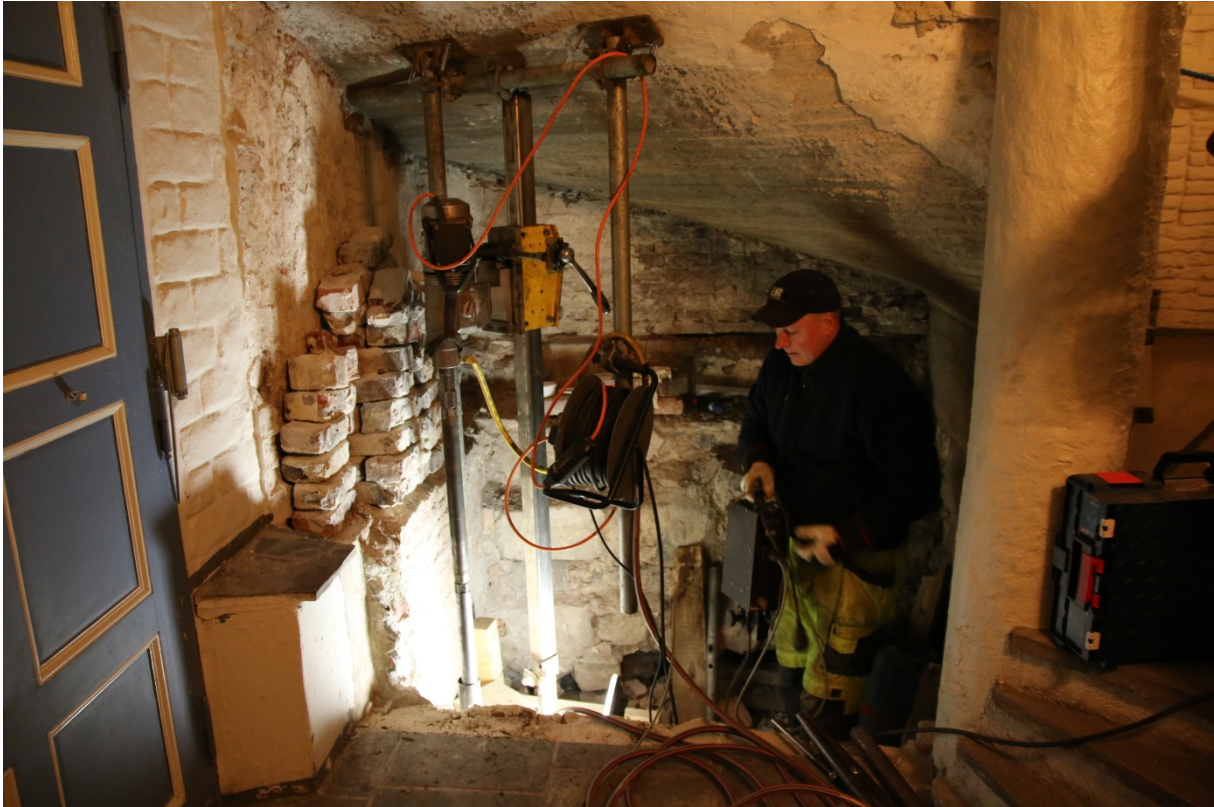
Figur 5: Arbeidsbilde, boring i Blåtårn. Foto av NFF. Foto-nr: Cf35274_NIKU_0033
