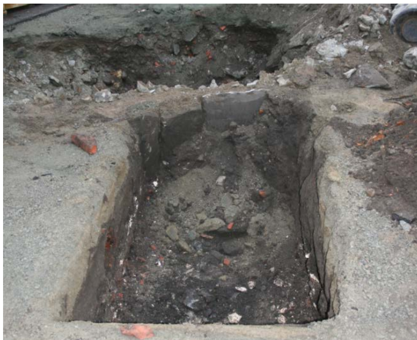
Figur 3. Prøvehull som ble tatt i forbindelse med sjekk av grunnforholdene. Sett mot S. Foto: Da_61261_001.
