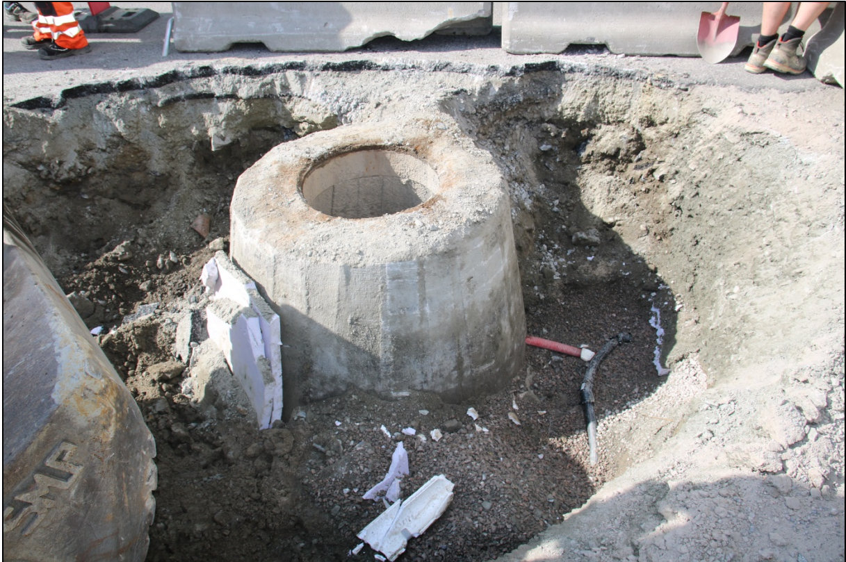
Figur 6. Gammel kum ved overgangen etappe 2 og 3. Sett mot VSV. Cf35168_NIKU_664516.
