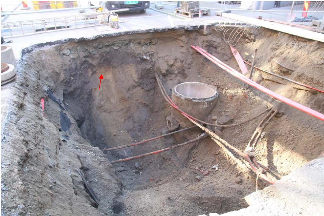
Fig. 5 Hullet nesten ferdiggravd. Sett mot ØSØ. Den svarte duken som dekker fjernvarmeledningen vises til venstre. Gulbrun undergrunn av sand/grus vises i profilen lengst øst (rød pil). Da60281_005.
