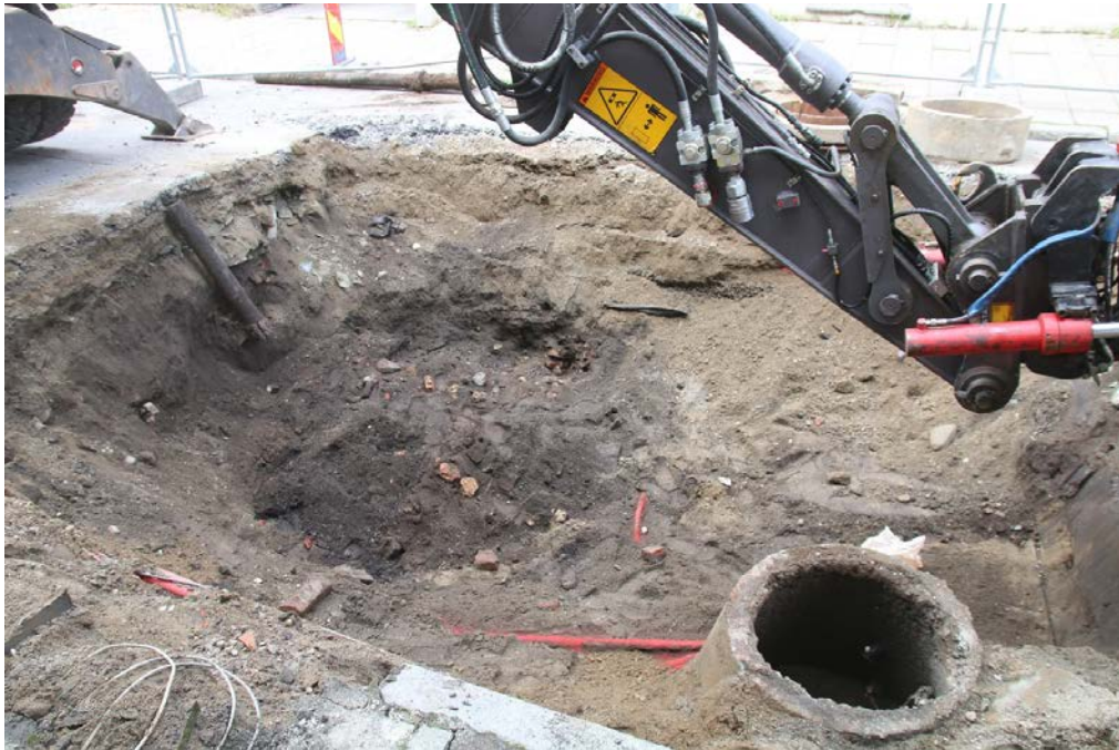
Fig. 2 Hullet under graving. Viser omrørte masser i ledningsgrøfter, kum i SØ-hjørnet og den mørkbrune fyllmasse i en avfallsbinge/grop i hullets NV-hjørne. En avbrukket del av et oppgravd gassrør vises ved profilen til venstre. Da60281_002.
