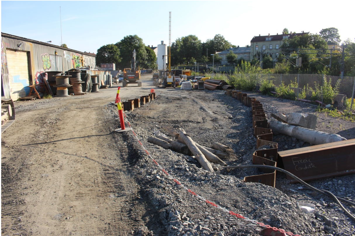
Figur 12: Den østlige delen av tiltaksområdet før graving. Tiltaksområdet begrenset seg til mellom de to spuntveggene, samt om lag en meter i ytterkant på begge sider. Sett mot nordøst. Foto nr: Cf53513_NIKU_20.
