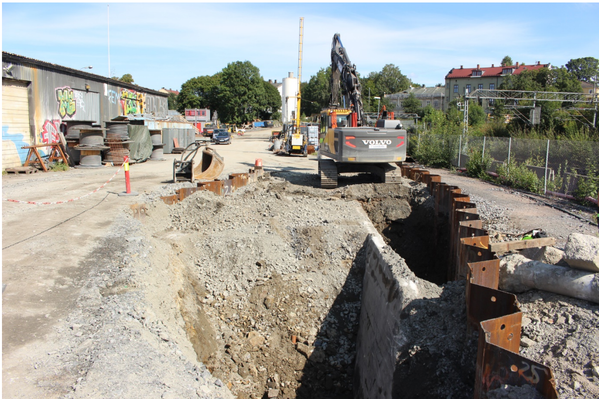
Figur 13: Betongfundament som var satt ned gjennom hele den østlige delen av tiltaksområdet. Sett mot nordøst. Foto nr: Cf53513_27.
