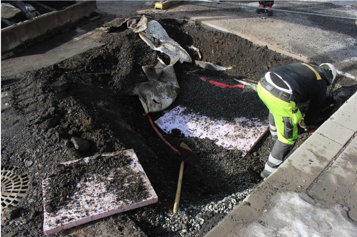
Figur 1: Strømkabler påtruffet på omlag 0,5 m dybde. Sett mot sørvest. Foto-nr: Cf53509_NIKU_05.
