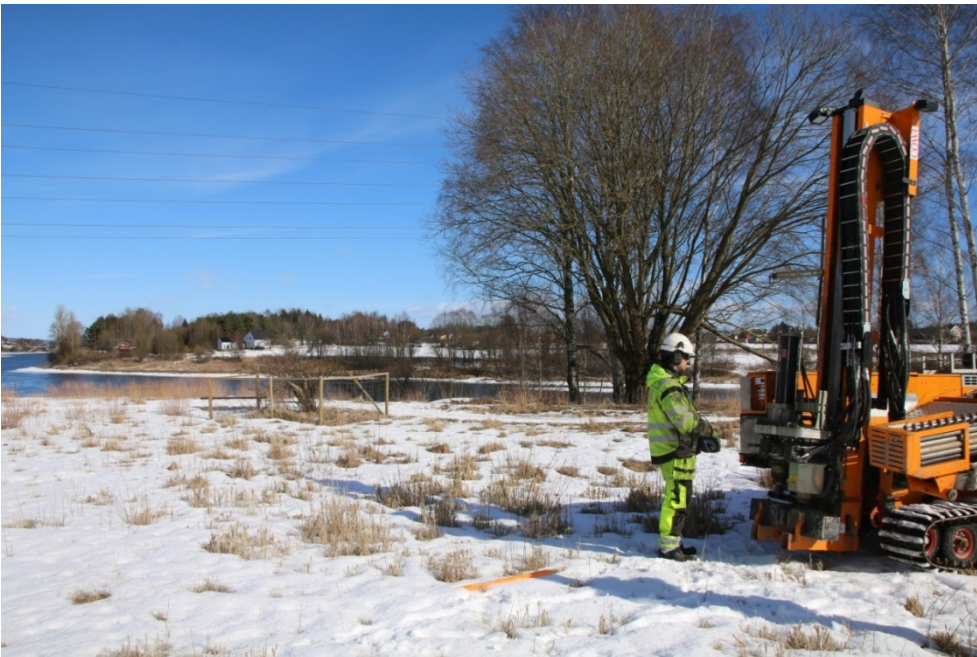
Figur 7: Borepunkt SS-12008, oversiktsbilde. Sett mot NØ. Foto-nr: Cf53397_NIKU_0018
