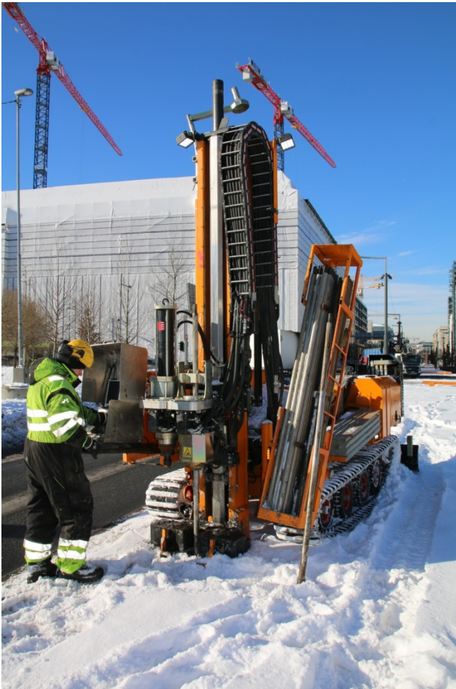
Figur 2: BP5, oversikt. Sett mot V. Foto-nr: Cf53338_NIKU_0006.JPG
