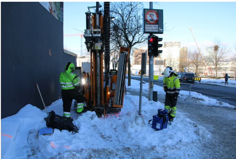
Figur 23: BP35, oversikt ved krysset Bispegata/Oslo gate. Sett mot VNV. Foto-nr: Cf53338_NIKU_0040.JPG
