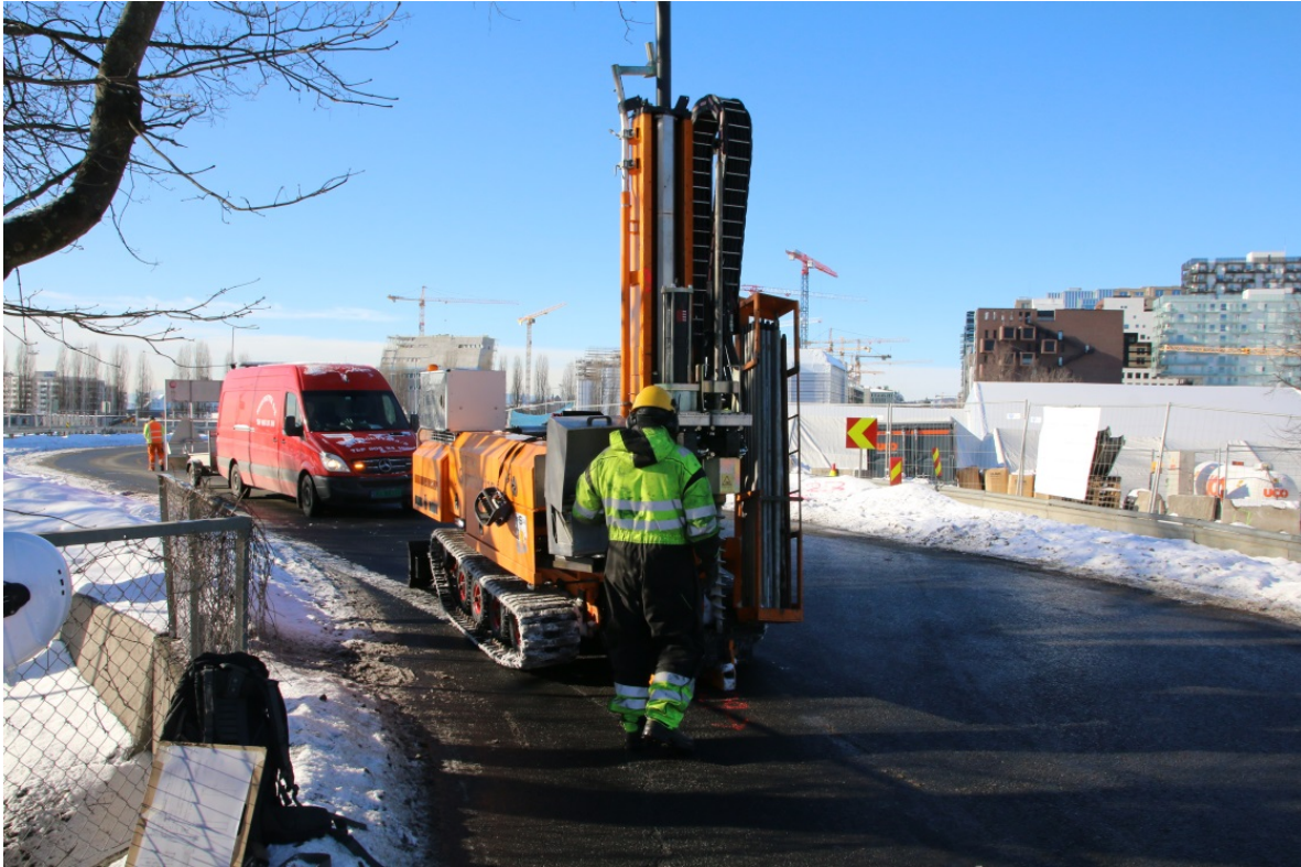
Figur 6: BP29, oversikt. Sett mot V. Foto-nr: Cf53338_NIKU_0010.JPG
