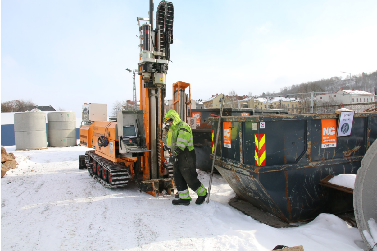
Figur 34: BP19, oversikt. Innenfor anleggsområdet til Follobanen. Sett mot SØ. Foto-nr: Cf53338_NIKU_0057.JPG
