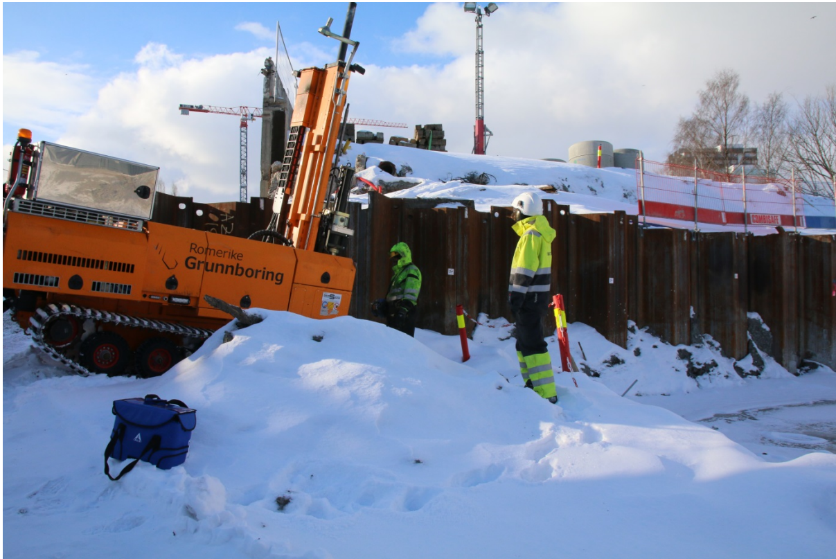
Figur 38: BP24, oversikt. Sett mot V. Foto-nr: Cf53338_NIKU_0063.JPG
