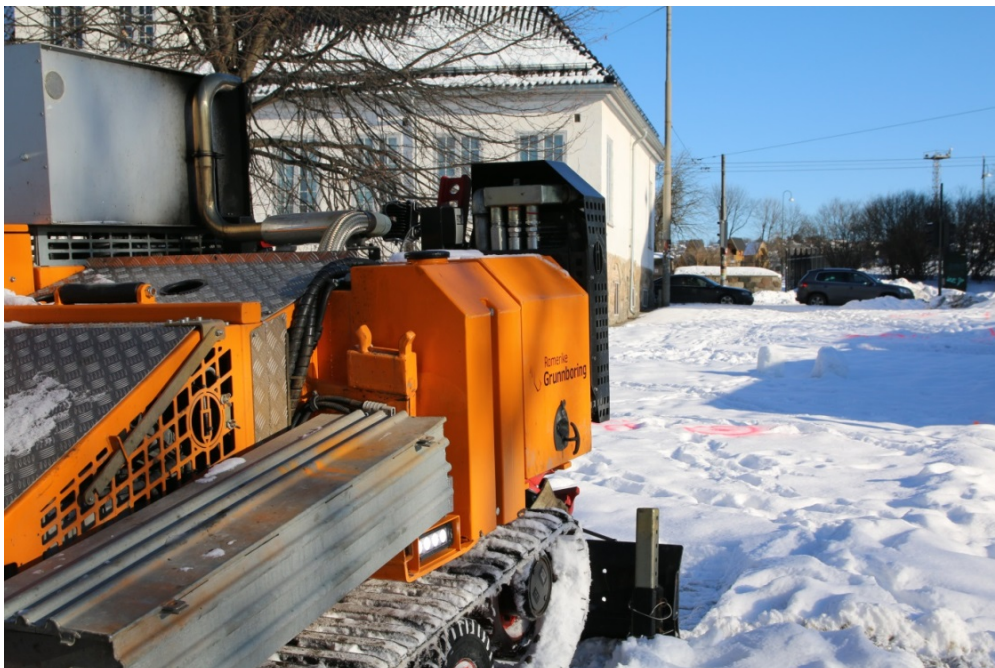
Figur 11: BP30, oversikt, i grøntpartiet sør for Ladegårdshagen. Sett mot Ø. Foto-nr: Cf53338_NIKU_0020.JPG
