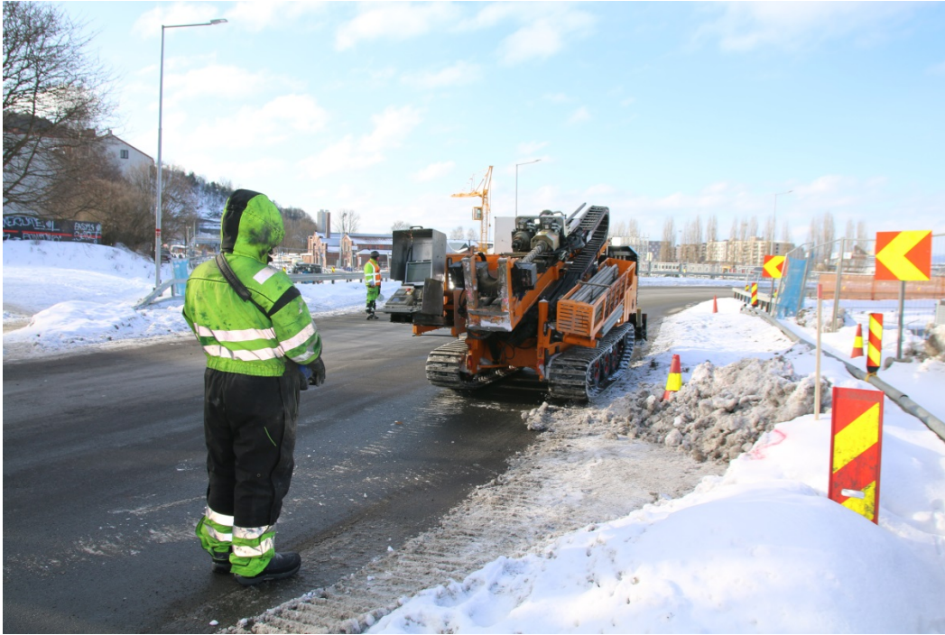
Figur 27: BP27, oversikt. Borepunktet lå i ny midlertidig vei. Sett mot SV. Foto-nr: Cf53338_NIKU_0045.JPG
