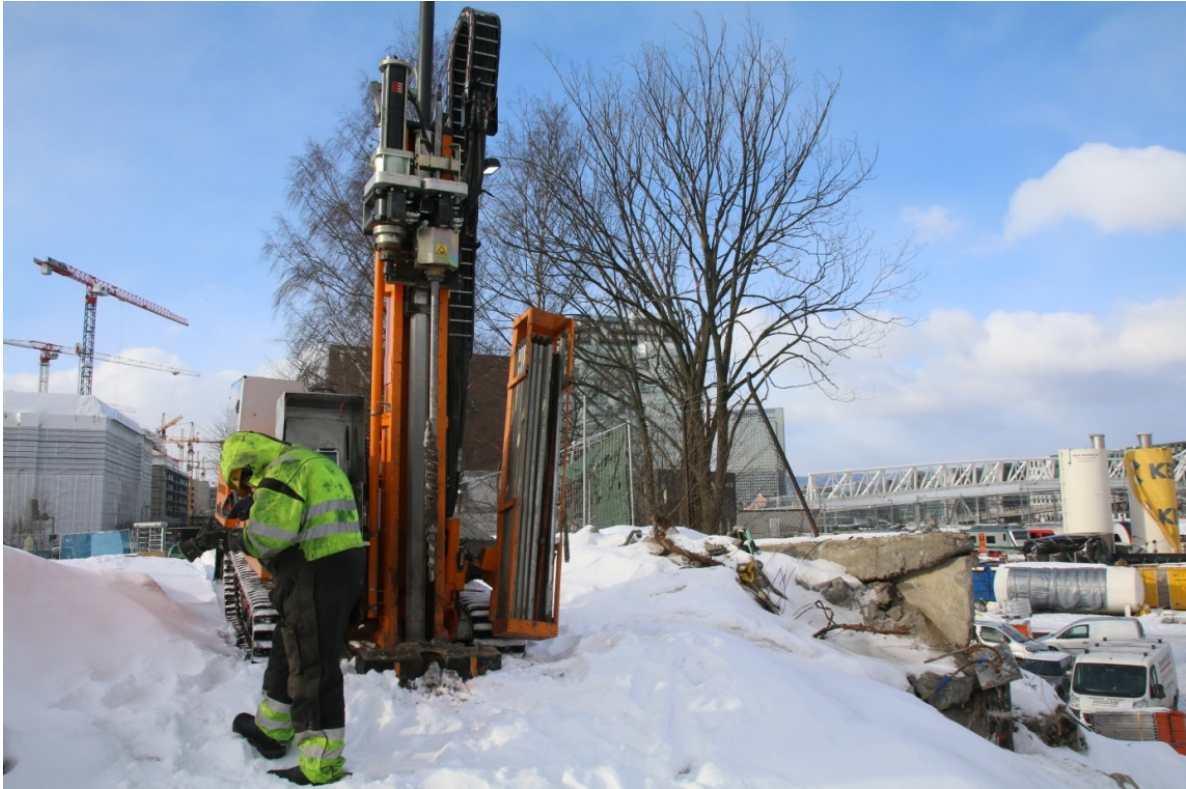
Figur 35: BP22, oversikt. Sett mot V. Foto-nr: Cf53338_NIKU_0060.JPG
