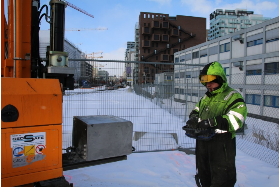
Figur 28: BP12, oversikt. Sett mot V. Foto-nr: Cf53338_NIKU_0047.JPG
