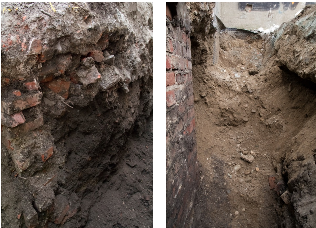
Figur 10 og 11. T.v. Detaljbilde av mur og t.h. bilde av gjenfylt sand i vest. Tatt mot Ø og V. Da62345_NIKU_12 og Da62345_NIKU_13.
