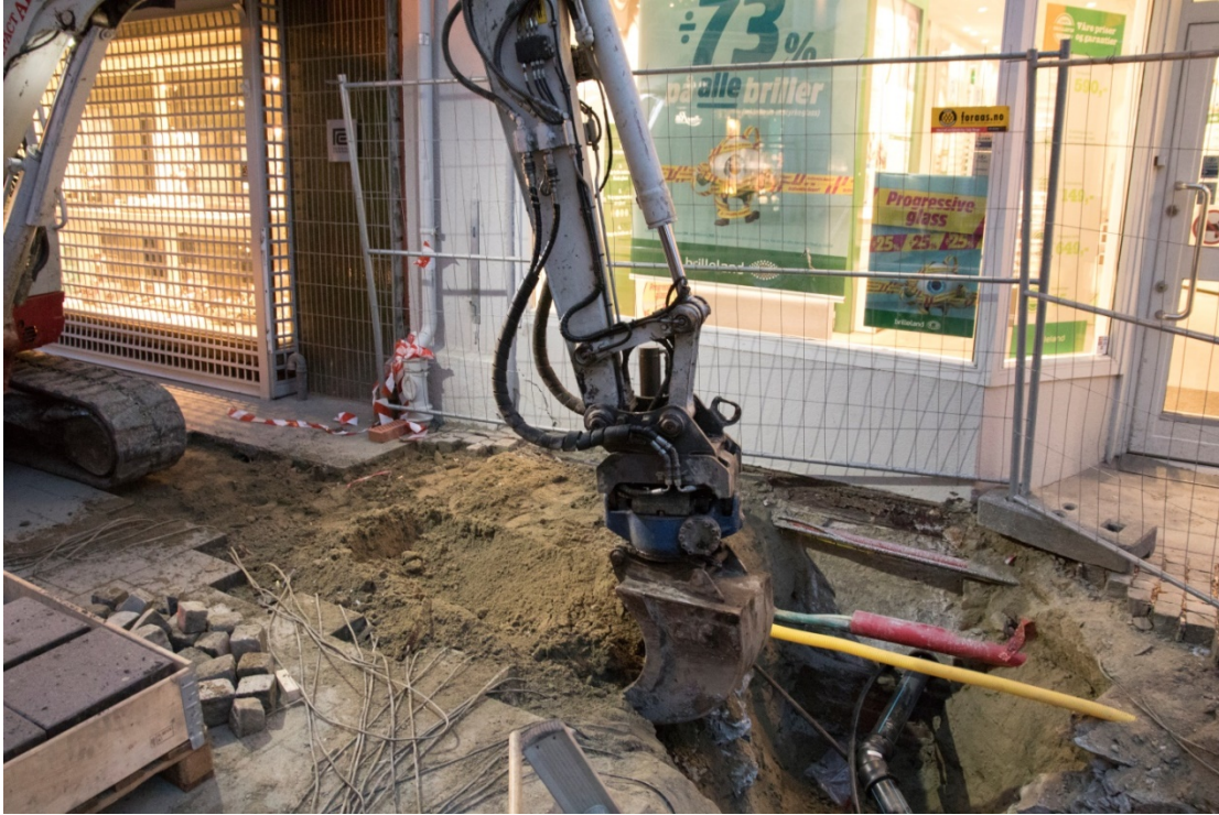
Figur 6. Arbeidsbilde fra overvåkning av sprinkelvanns grøft. Tatt mot Ø. Da62348_NIKU_05.
