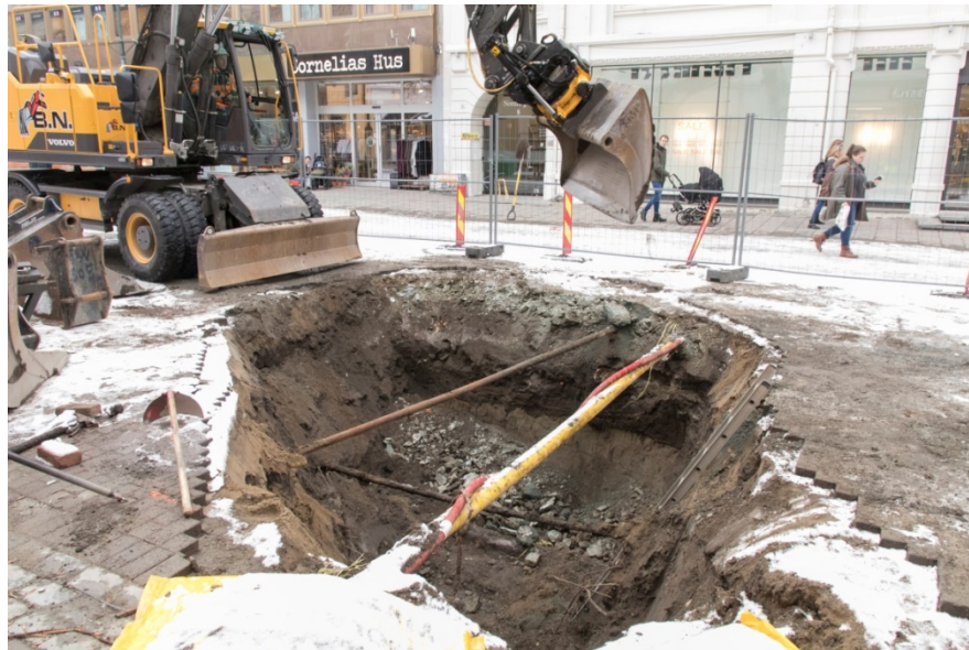
Figur 4. Oversiktsbilde av graving av grøft til kum. Tatt mot SV. Da62348_NIKU_04.
