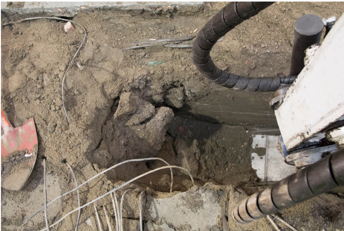
Figur 7. Arbeidsbilde fra overvåkning av sprinkelvanns grøft. Tatt mot Ø. Da62348_NIKU_06.
