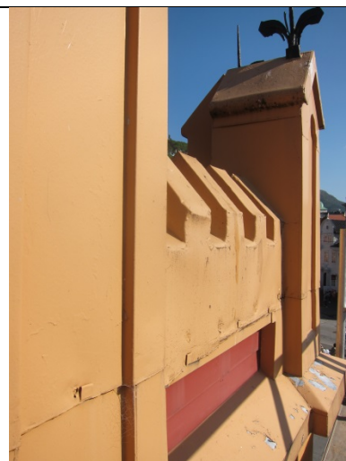
Øvre del av fasaden med metallbeslag
