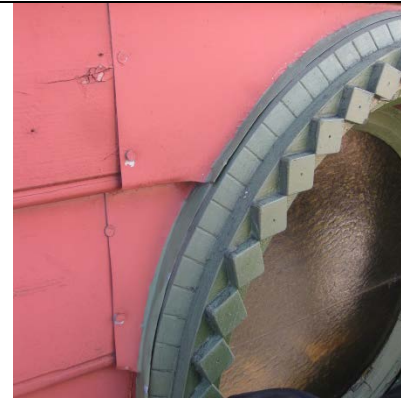
Detalj fra kopigerikt loftsvindu
