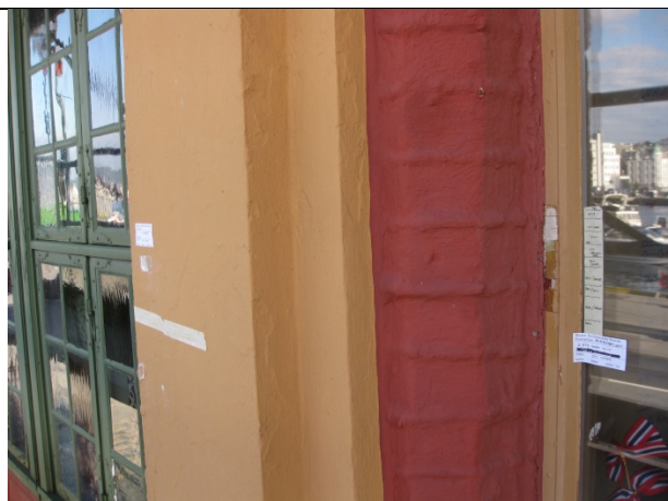
Detalj fra murtasken som viser forskjell i overflaten mellom slemmet og malt tegl og pussede flater. Forskjellen følger fargen.
