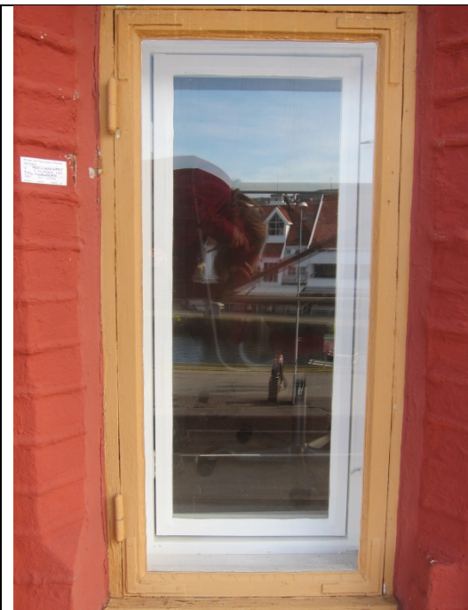
Vindu i Murtasken, 3.etasje. Trolig fra 1950-årene
