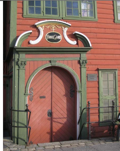
Norddør i vestfasade
