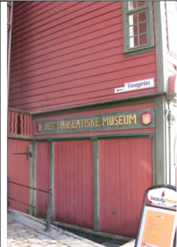
Nordfasade, fremre, nedre del
