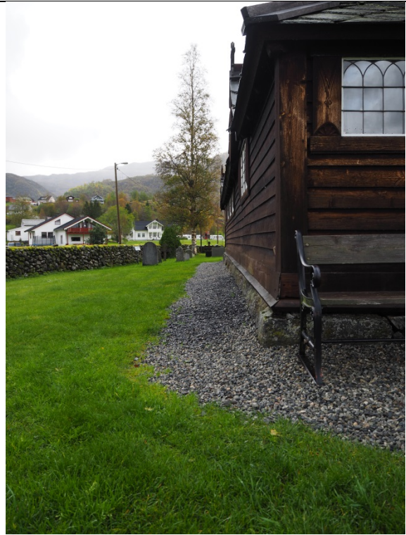
Kirkens svalgang og nordside. Hellingen utfra kirken synes tilstrekkelig, og drenering samt grus bidrar til at vann ikke blir stående. Kirka har imidlertid hatt problemer med fuktig grunn. Dreneringen må derfor holdes under oppsikt.
