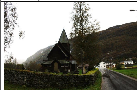
Kirka, kirkegårdsmur og Kyrkjevegen i nord sett fra øst.
