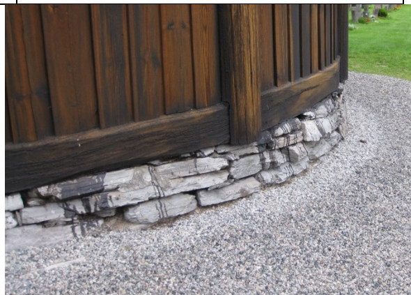
Detalj bilde av grunnmur.
