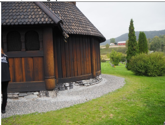
Sydsida av apsidens grunnmur. Noter linjen i grusgangen som dannes takke være taktspringet. Dybden gikk igjenn rundt hele kirka.
