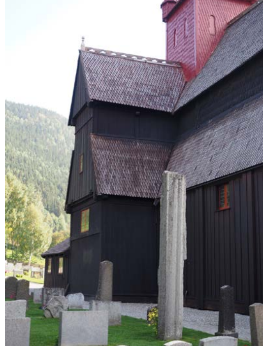
Tak med tydelig større behov for tjærebreing enn ytterveggene på nordsida.
