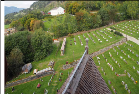
Nordre del av kirkegården sett fra tårnet. Bekken løper i linje med treene. Til venstre i bilde skjuler seg en kraftig helling bak treene ned mot bekken. Hellingen er blitt fylt på med sjaktmasser.
