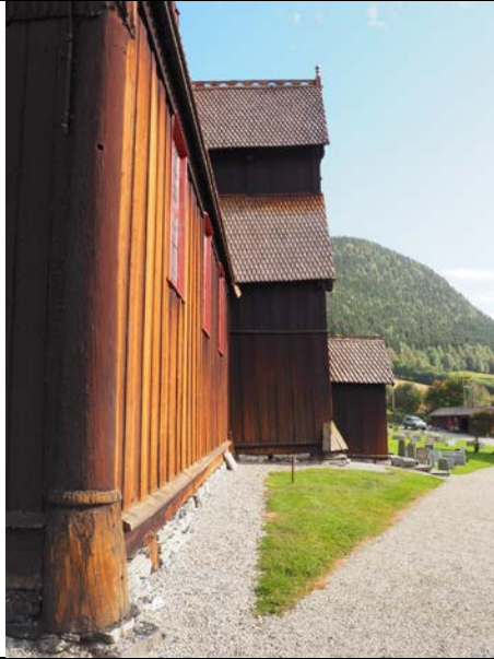
Bildet viser det sydvestlige hjørnet og hjørnestolpen av skipet. Legg merke til den utstikkende gradrennen.
