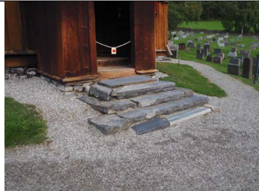
Stentrapp og grunnmur ved inngang til korsarmens sørportal.
