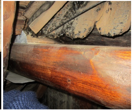
Takrenne i tre som går gjennom loft over sakristi. Den kan inspiseres ved å kripe opp gjennom luke i taket. Se bilde til venstre hvor Haugen, NIKU, inspiserer etter tillatelse fra kirkevergen.
