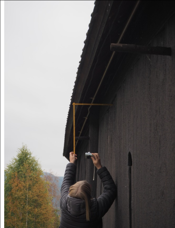
Takutstikk på langskip er ca 40 cm og således nok så greit selv om det ikke finnes noen takrenne.
