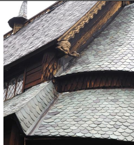
Møtet mellom det noe høyere langskipet, apsiden og svalgangen er dekket med gradrenner.
