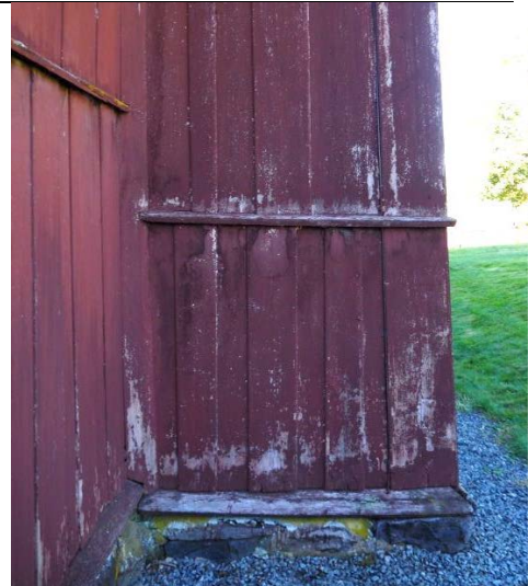
Østvegg i skip ved kor
