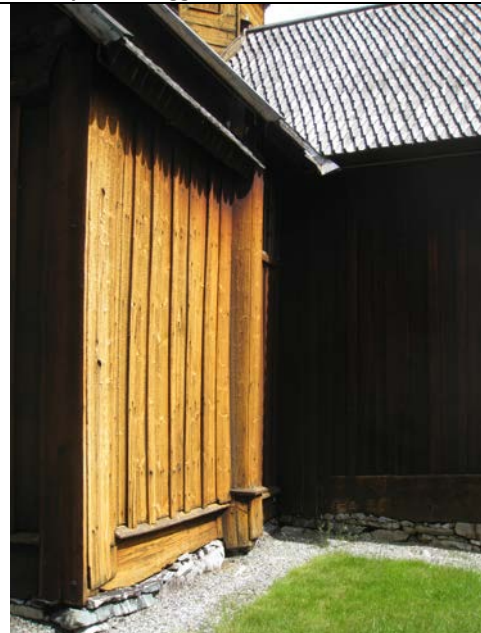
Kirkens sørvestre side, hjørne våpenhus – søndre korsarm. Gratrenna går godt ut fra takflaten
