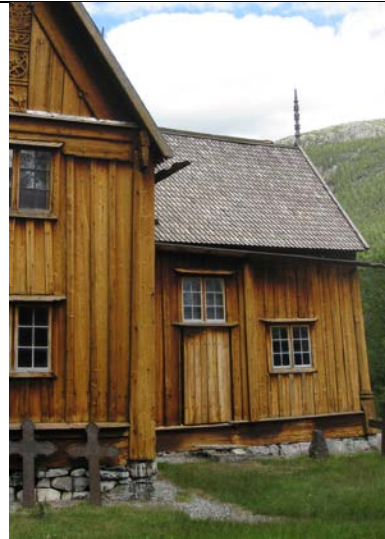
Kirkens sydside. Legg merke til takrennene
