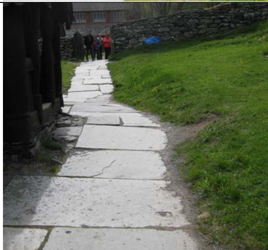
Hellegang rundt kirken: Vestside hvor terrenget skråner ned mot kirken.
