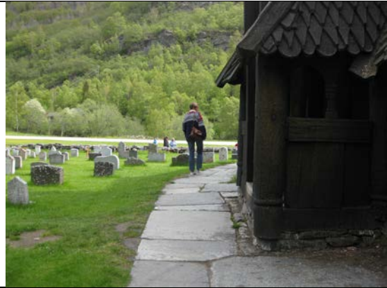
Hellegang rundt kirken: Nordside hvor terrenget skråner vekk fra kirken.
