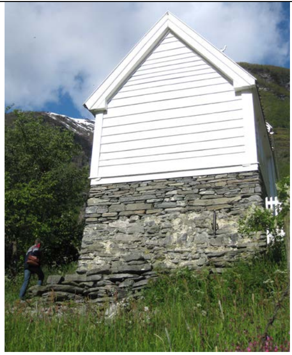
Kirkas østside hvor grunnmuren er bygget opp.
