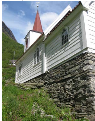
Øst del av sørvegg
