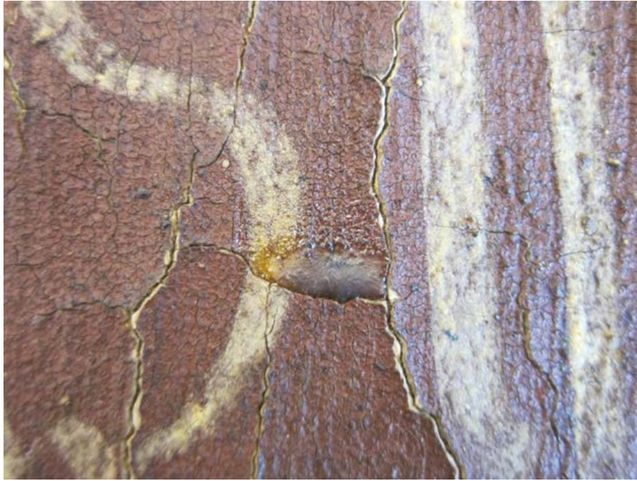
Bilde 11: Fernissen er svært ujevnt påført og stedvis har fernissen rent og samlet seg der malingen har løftet seg fra underlaget.
