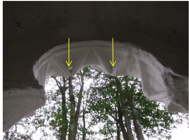
Figur 3: Detalj fra vestportalen sett fra innsiden og ut. Chevron med gjennomgående åpninger (piler). Foto: NIKU 2016
