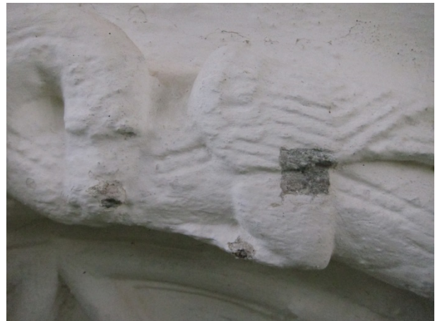
Figur 13: Avdekning ved nordre drage. Flere kalklag har tilslørt den sirlig huggete steinskulpturen. Ved fjerning av kalklagene de fine detaljer bedre synlig. Det er ikke funnet fargespor i dette område. Foto: NIKU 2016
