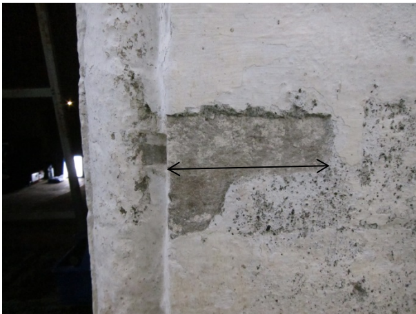
Figur 12: Avdekning ved portalens nordre side, ca. en halv meter over gulv. Opprinnelig veggpuss flater ut mot veggkanten. Foto: NIKU 2016
