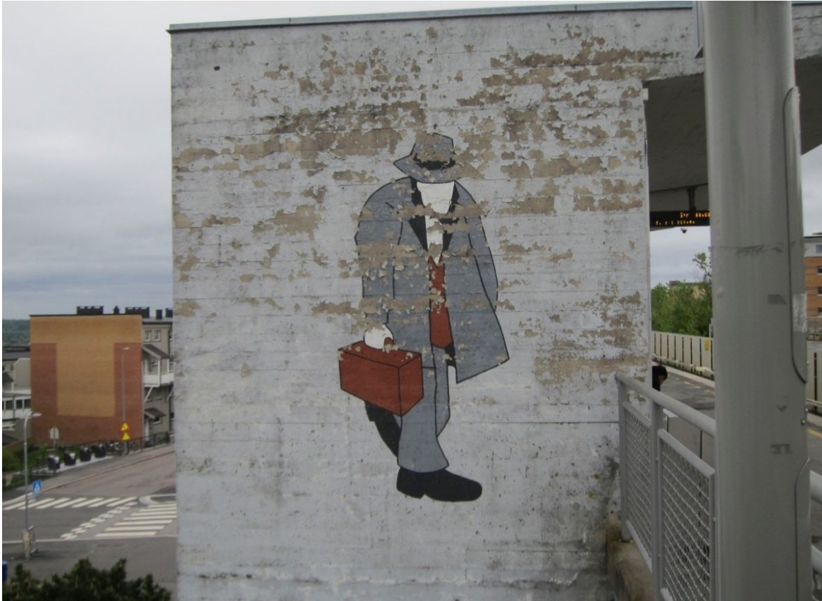
Figur 9: Veitvet T-banestasjon. Opprinnelig veggmaleri ved utgående perrong, vendt ut av byen. Før rehabilitering.
