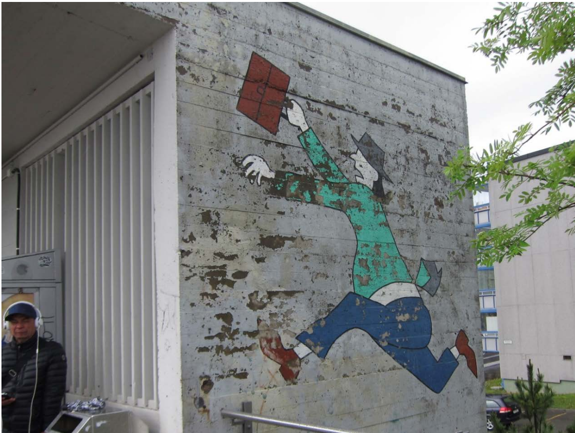
Figur 5: Veitvet T-banestasjon. Opprinnelig veggmaleri ved inngående perrong, vendt ut av byen. Før rehabilitering.
