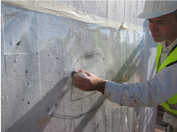
Figur 11: Overføring av motivet med hjelp av pauser.
