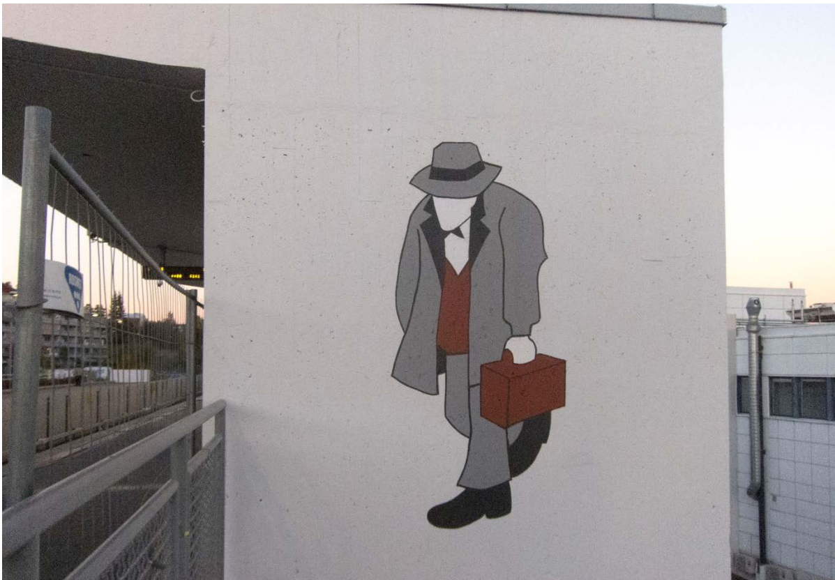
Figur 8: Samme veggavsnitt som i bilde ovenfor, med nyoppmalt motiv. Etter rehabilitering.
