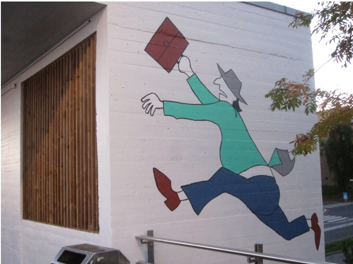
Figur 6: Samme veggavsnitt som i bilde ovenfor, med nyoppmalt motiv. Etter rehabilitering.
