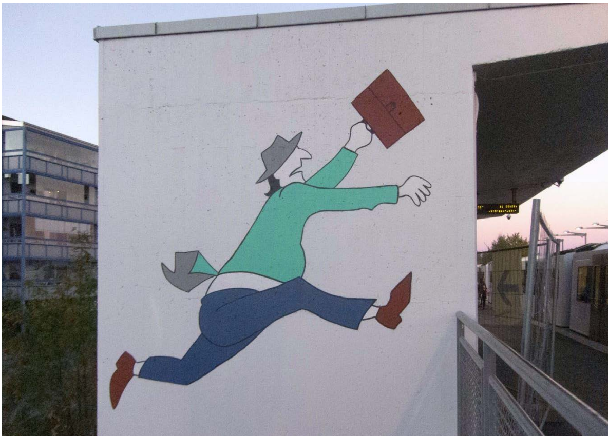
Figur 4: Samme veggavsnitt som i bilde ovenfor, med nyoppmalt motiv. Etter rehabilitering.
