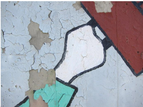
Figur 24: Detalj av opprinnelig motivet ved inngående perrong, vendt mot sentrum, før rehabilitering. Opp- og avskallinger i maling ned til betong.
