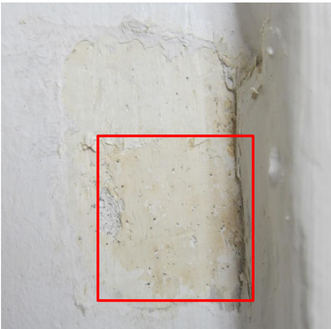
Figur 5 Korridor 3. etasje, østre fløy. Vegger og tak er malt med brukket hvit limfarge.
