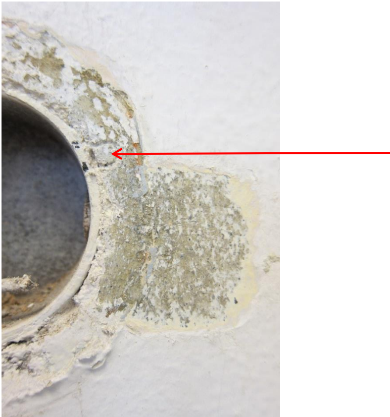
Figur 6 Korridor 2. etasje. Rester av blålig grå maling bak eldre deksel.
