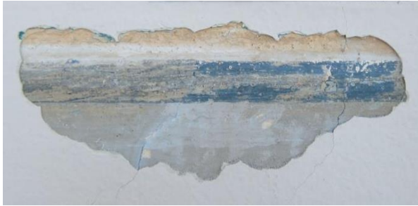
Figur 8 Rom 206. Detalj avdekket område ca. 260 cm over gulv. Fotoet viser en blå malt strek, lys gråblå veggfarge under streken og rester av hvit vegg- og himlingsfarge over streken (det beige området øverst i avdekkingen er senere maling). Foto: NIKU 2016.
