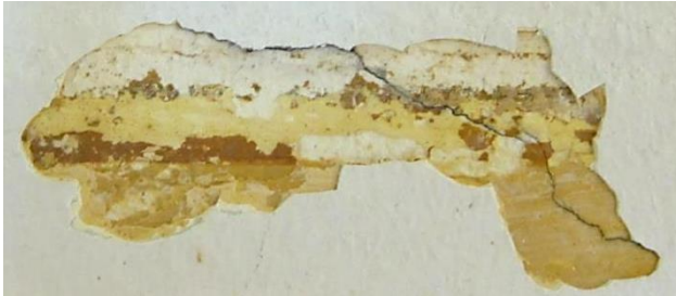
Figur 10 Rom 207. Detalj. Avdekket område ca. 260 cm over gulv. Fotoet viser opprinnelig maling. Avdekkingen viser rester av en brun malt strek. Bak streken ser man en lys blek gul veggfarge. Dette er den opprinnelige veggfargen på nedre del av vegg. Foto: NIKU 2016
