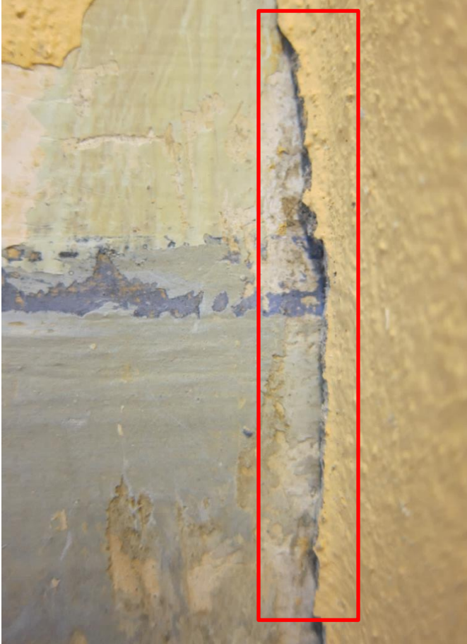
Figur 4 Korridor 3. etasje, søndre fløy. Nedre del av vegg var malt lys blå, øvre del og himling var malt hvit. Overgangen er markert med en mørk blå malt strek. Fargesettingen var den samme som i 1-sengs-pasientrommene 106/206/306.
