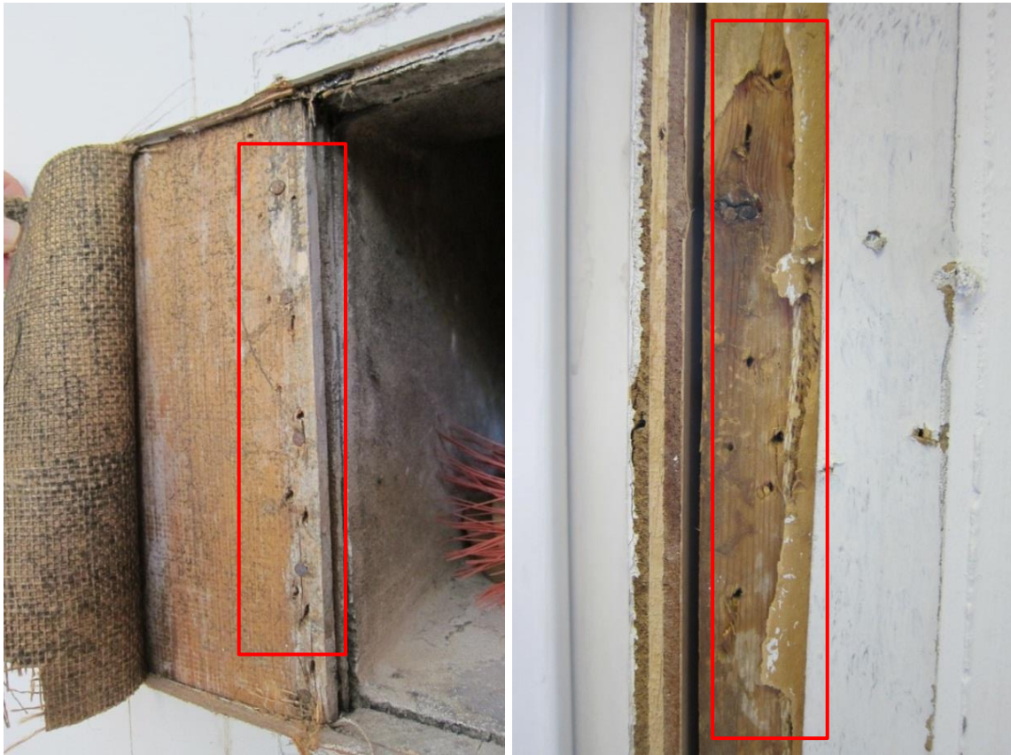
Figur 15 Rom 114. Åpning av veggplater. Til venstre: vestvegg, ved lufterventil. Til høyre: Nordvegg, ved vindu, bak høyre vindusgerikt. Huller etter eldre stifterekke og rester av papir er markert ut. Foto: NIKU 2016.
