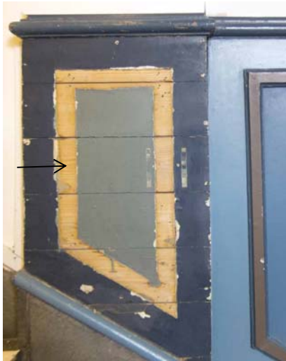
Nordstrand vgs, plan 1. Original brystningspanel med spor etter fyllingslistene (pil).
