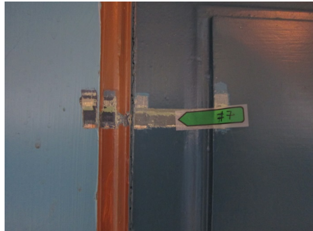
Dør i vestibyle på plan 3. Målepunkt #7 ved undersøkelse med håndholdt XRF.
