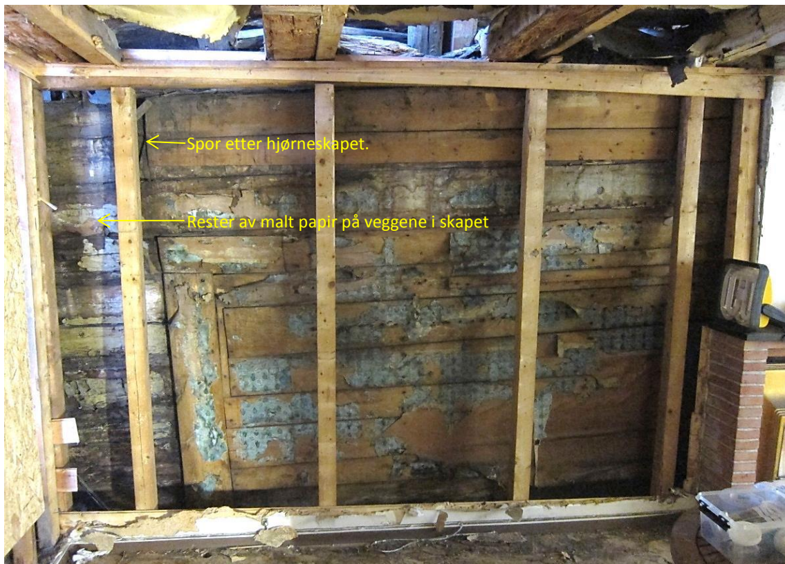
Nordvegg. Liggende og stående utjevningsbord på lafteveggen før tapetsering. Utjevningsbordene avsluttet med stående bord mot hjørneskapet i nordvestre hjørne
