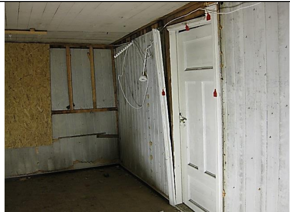
Rommet sett mot nordvest
