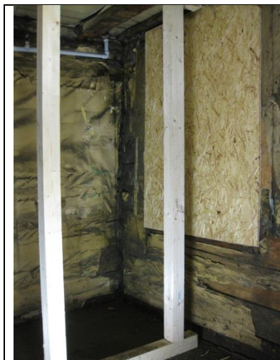
Rommet sett mot nordvest
