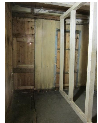
Rommet sett mot øst
