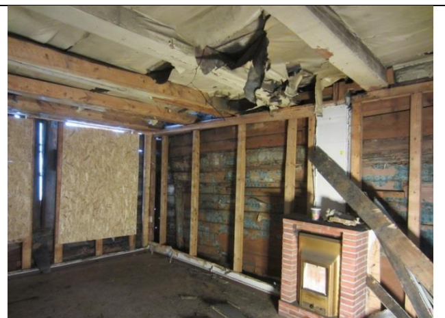
Rommet sett mot nordvest
