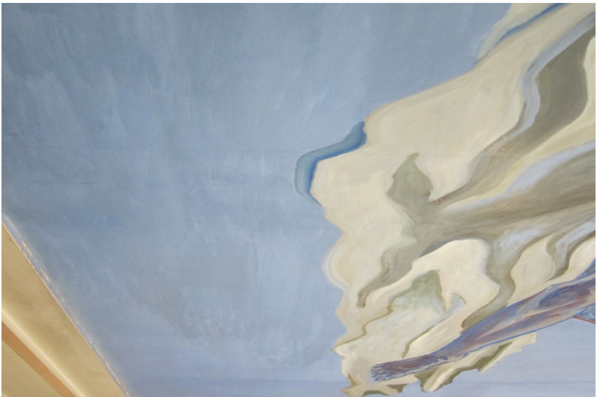
Figur 6 Samme detalj som i figur 5 etter behandling. Malingen er festet, avskallinger kittet og retusjert, samt overflaten renset.
