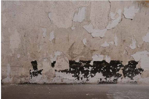
Figur 56: Maltlager. Detalj fra østveggen nedre del med spor etter en malt sort fotlist. Foto: NIKU 2017
