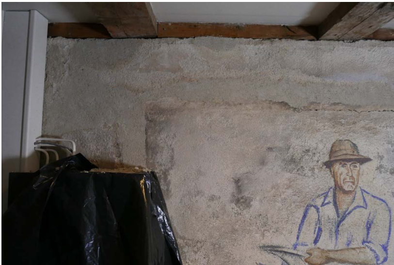
Figur 11: Detalj i vestre veggmaleri. Pussreparasjoner (piler). Foto: NIKU 2017
