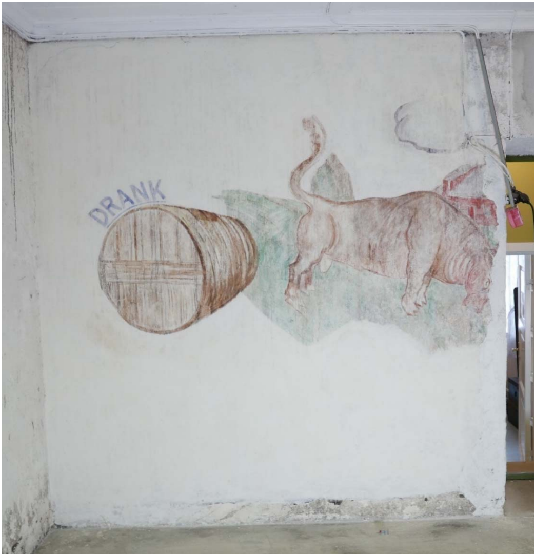
Figur 35: Veggmaleriet «Drank». Tilstand etter rensing, grundering av skader og fire lag med kalk på veggen rundt motivet. Foto: NIKU 2017
