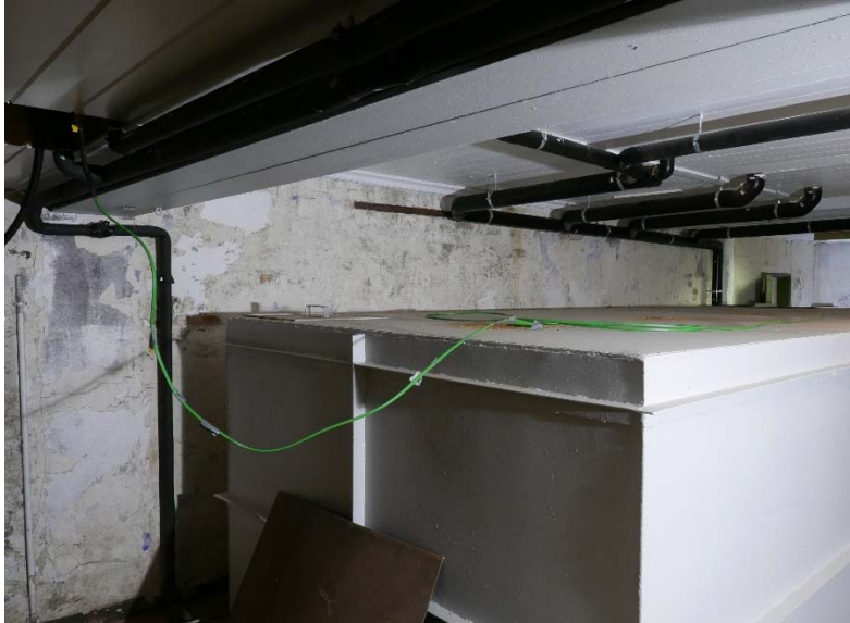
Figur 50: Maltlager, østvegg, søndre del, med vanntanken foran. Foto: NIKU 2017
