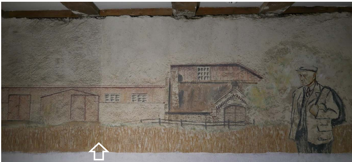
Figur 17: Vestre veggmaleri, midtre avsnitt under behandling. Avsnitt til venstre for pilen er rensed. Foto: NIKU 2017
