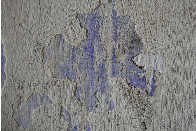
Figur 53: Detalj fra østveggen bak vanntanken. Blå malingsrester. Foto: NIKU 2017
