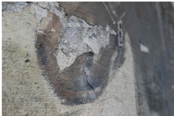
Figur 10: Detalj i østre veggmaleri. Oppskalling. Tilstand før behandling i 2017. Foto: NIKU 2017
