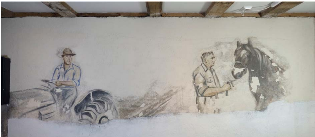
Figur 18: Østre veggmaleri under behandling. Det er gjort pussreparasjoner, veggen rundt motivene er malt, avskallinger er grunnet og sprekker er kittet. Foto: NIKU 2017
