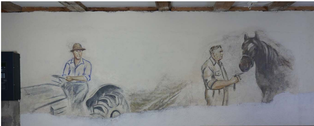
Veggmalerier i brennerikjeller, østre maleri. Helopptak. Tilstand etter behandling Foto: NIKU/Kaun 2017
