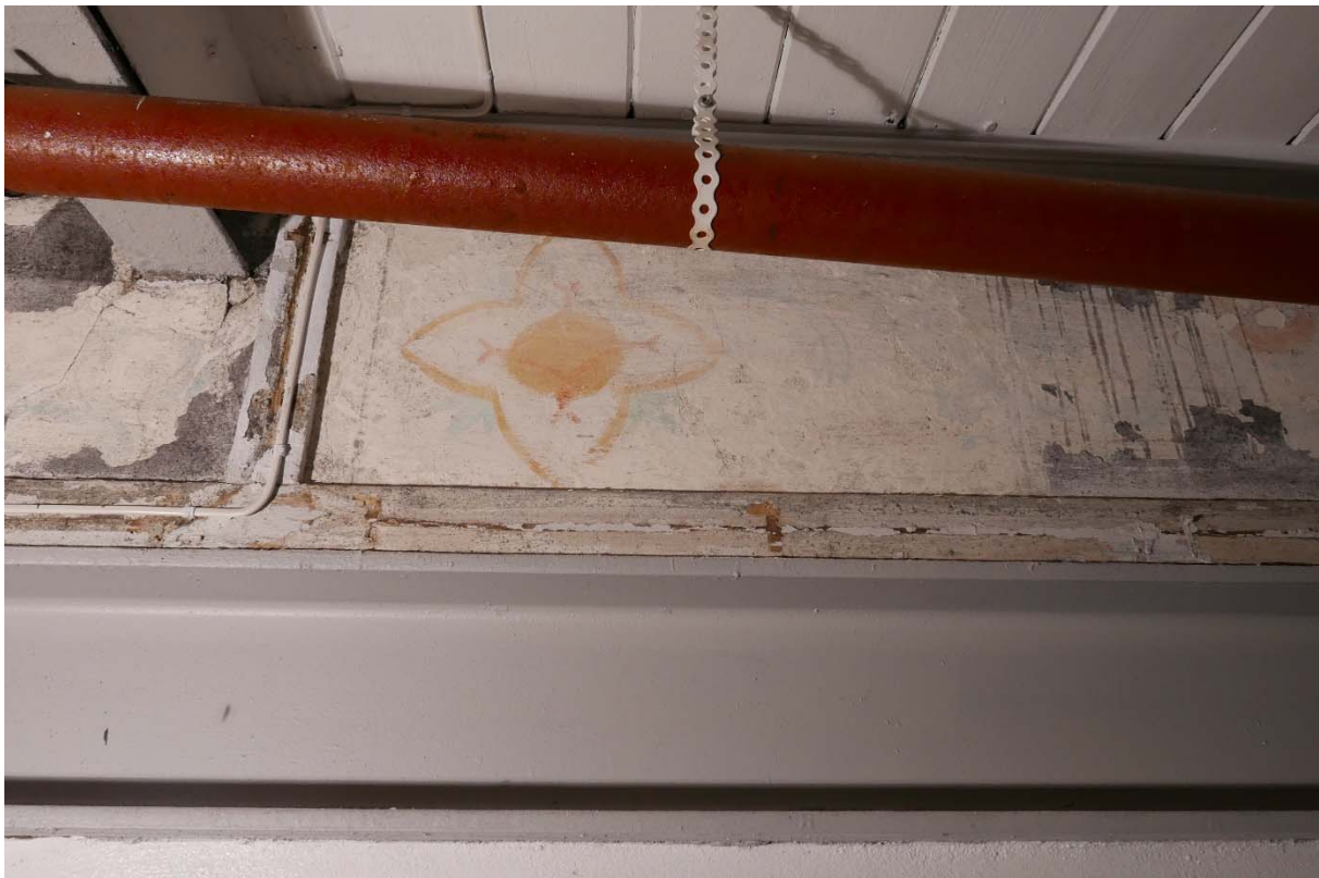
Figur 45: Detaljbilde som viser dekoren med blomst etter avdekking i midtre del. Foto: NIKU 2017
