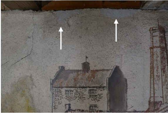
Figur 11: Detalj i vestre veggmaleri. Pussreparasjoner (piler). Foto: NIKU 2017
