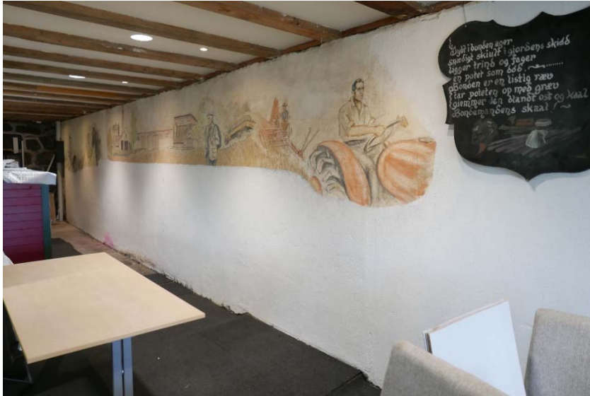
Figur 3: Brennerikjellerens sydvegg med veggmaleriene. Tilstand etter behandling. Foto: NIKU 2107
