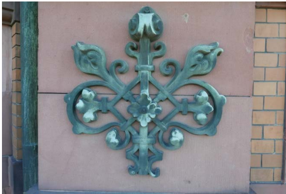
Figur 35: Kobberornament på fasaden mot Karl Johans gate. Kobberoverflaten er irret og fremstår i grønne farger.
