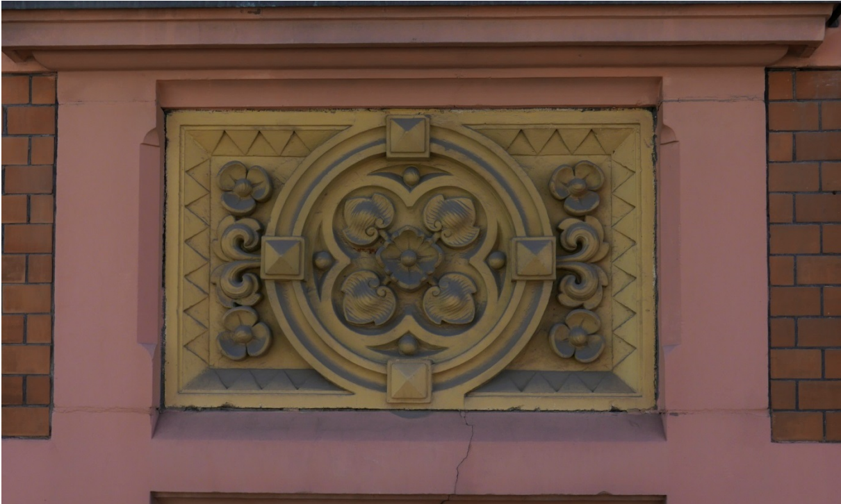
Figur 16: Detalj fra fasaden mot Universitetsgata. Ornament og omramming i støpt steinimitasjon, malt med gul og rosa maling.
