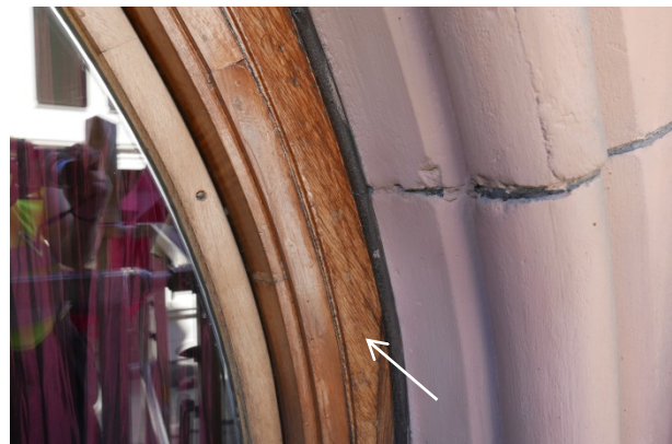
Figur 23: Detalj fra bilde til venstre. Den innerste delen av rammen kan være original (pil).
