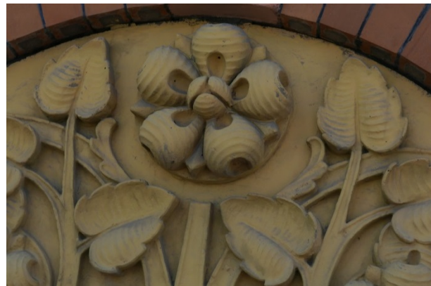
Figur 15: Detalj fra fasaden mot Universitetsgata. Ornamet i støpt steinimitasjon, detalj, malt med gul maling.
