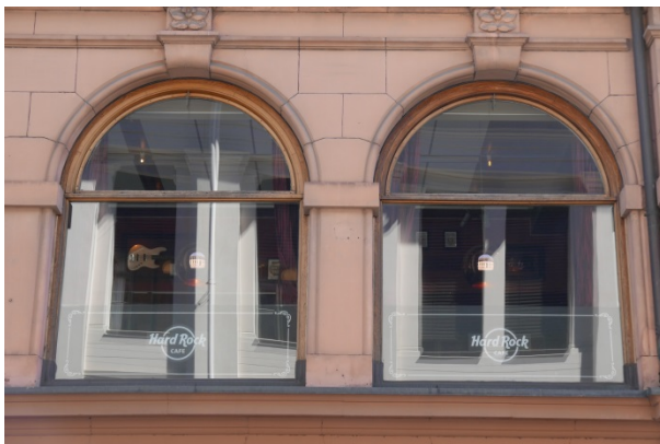
Figur 22: Store vinduer i 2. etg. mot Universitetsgata. Vinduene har lakerte eikerammer og moderne isolerglass.
