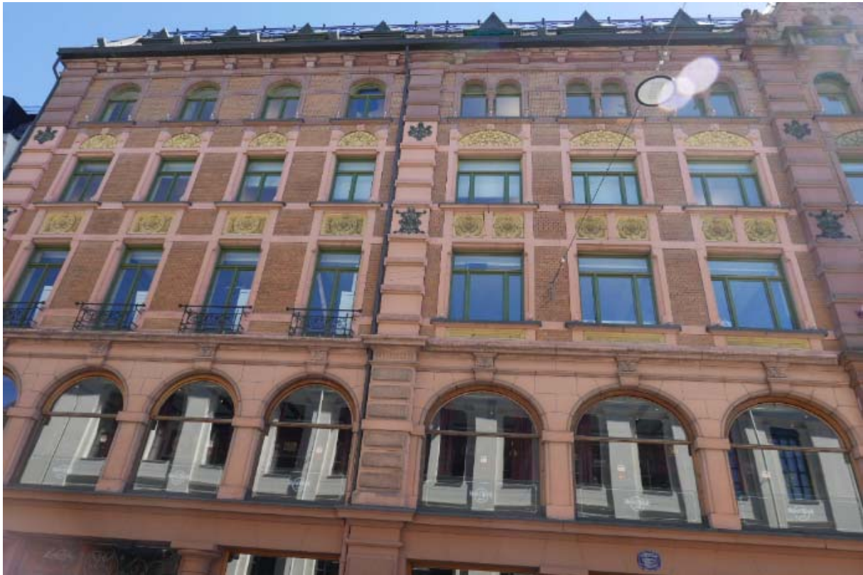
Figur 13: Fasade mot Universitetsgata, øverste etasje er et senere påbygg med naturstein, mens 2.-3. etasje har malte støpte elementer i en farge som harmonerer dårlig med natursteinen.
