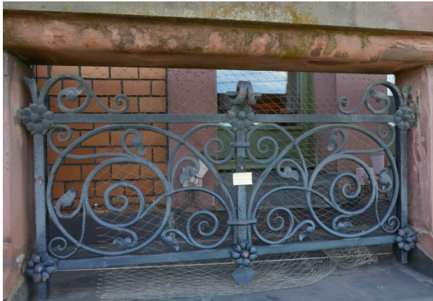
Figur 31: Opprinnelig smijernsrekkverk i loftsetasje mot Karl Johans gate.
