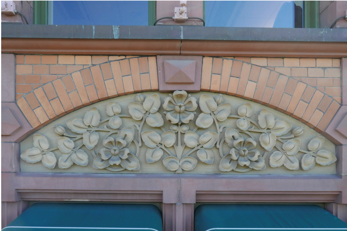
Figur 6: Dekorelement ovenfor vindu i 3. etasje mot Karl Johans gate. Ornamentet er hugget i gul sandstein.
