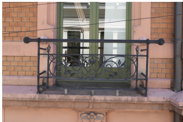
Figur 34: Fransk balkong i 3. etasje mot Universitetsgata med nyere smijernsrekkverk.
