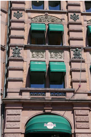
Figur 9: Bygningen er rikt artikulert med huggen dekor, ornamenten i kobber og vindusrekkeverk i smijern.
