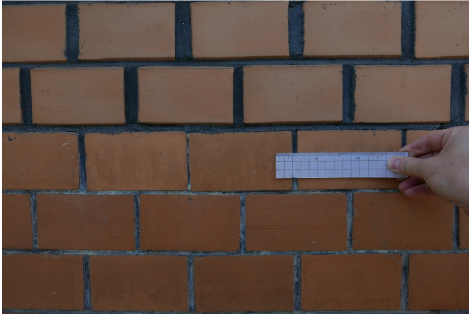
Figur 21: Vestfasade (Universitetsgata). Teglsteinsmur mellom 4. og 5. etasje. De nedre tre radene er opprinnelig murverk, mens de øvre to radene er sekundære. De sekundære teglsteinene er mindre i format, og fugene er dermed bredere enn de originale fugene.
