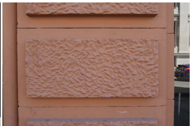
Figur 12: Støpt og malt kvader (steinimitasjon).
