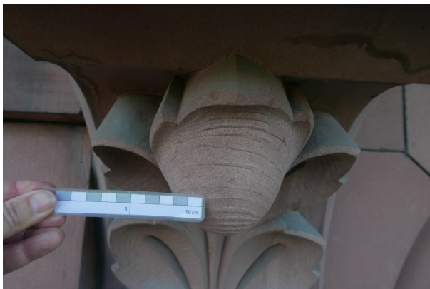
Figur 7: Dekorelement nedenfor balkong i loftsetasje mot Karl Johans gate. Ornamentet er hugget i rød sandstein.
