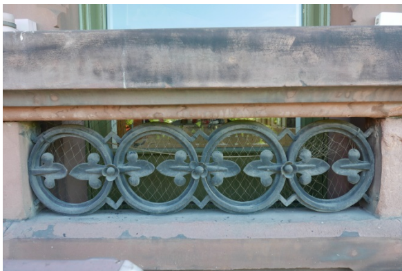
Figur 33: Opprinnelig smijernsrekkverk ved balkong i 3. etasje mot Karl Johans gate.
