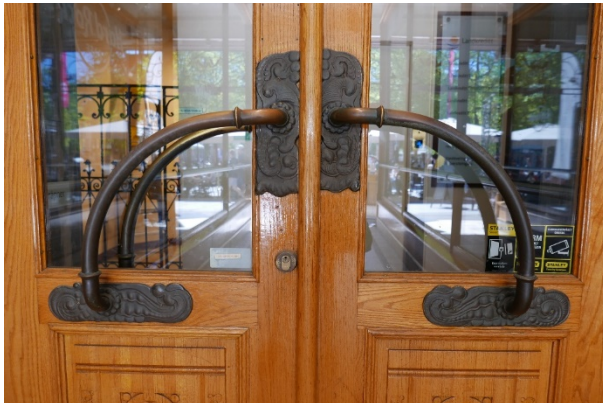
Figur 27: Dørhåndtak/Beslag, nybarokk. Eikedørene er overflatebehandlet med transparent lakk.
