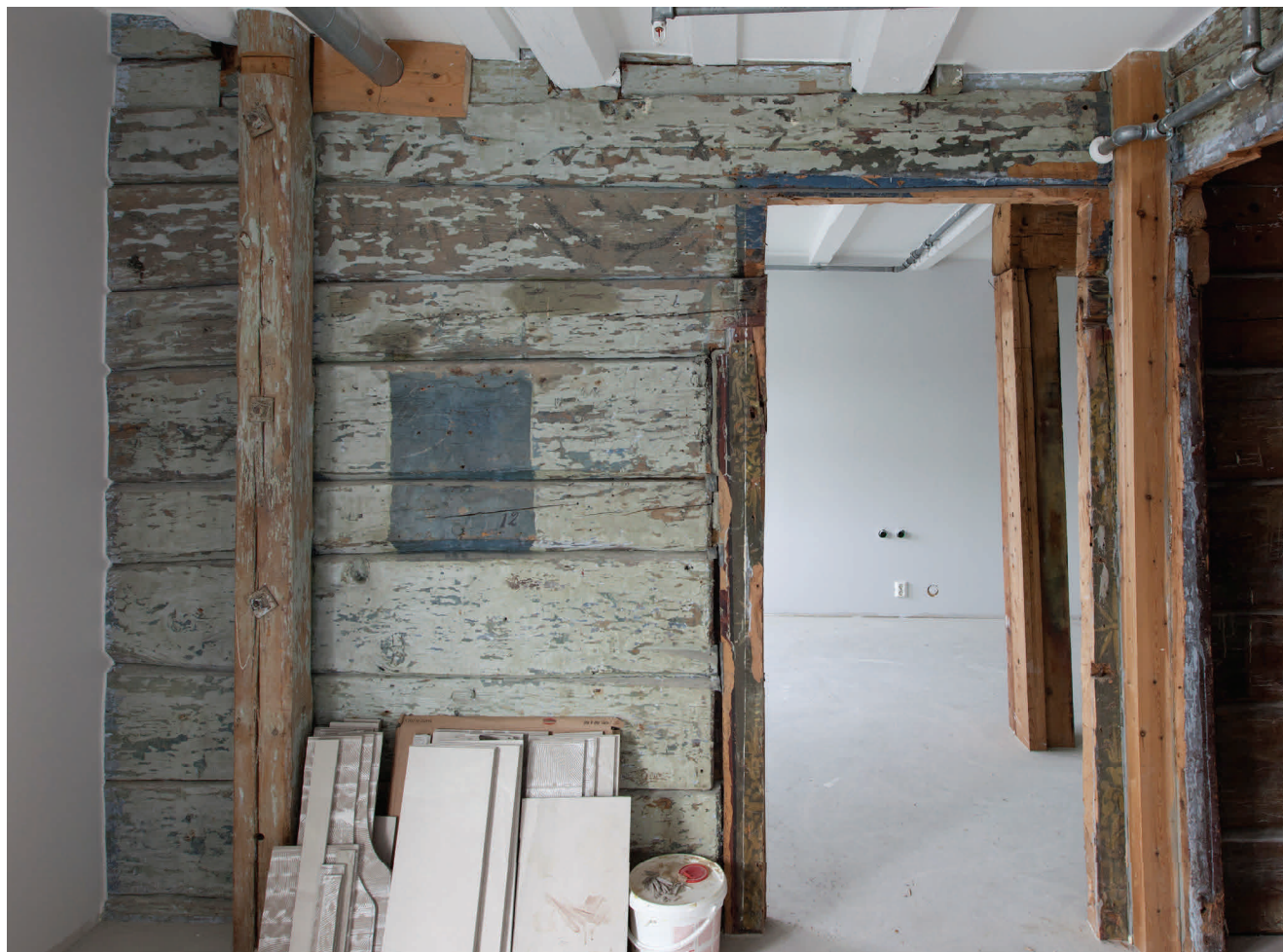
Vegg mot nord.
