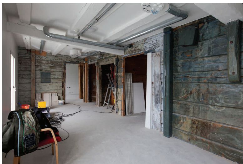
Rom 106 mot nord-øst
