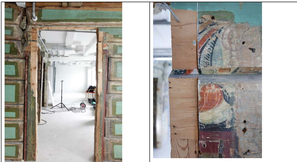
Døråpning mot syd med dekor som har vært dekket av sekundær belistning
