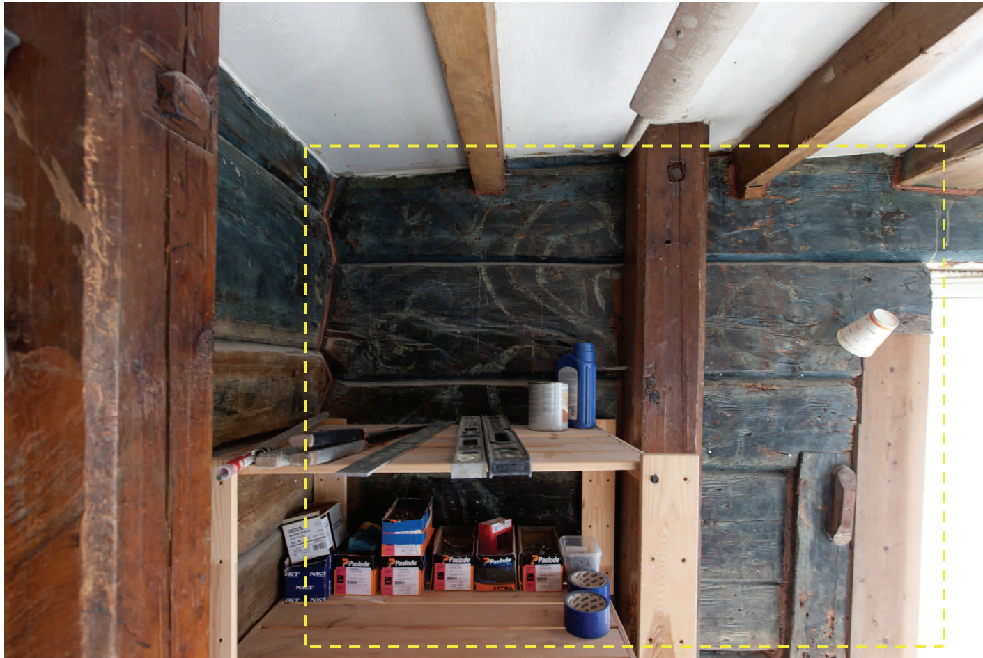
Vegg mot sør, øst for inngang, øvre veggdel. Opprinnelig trappeoppgang.
