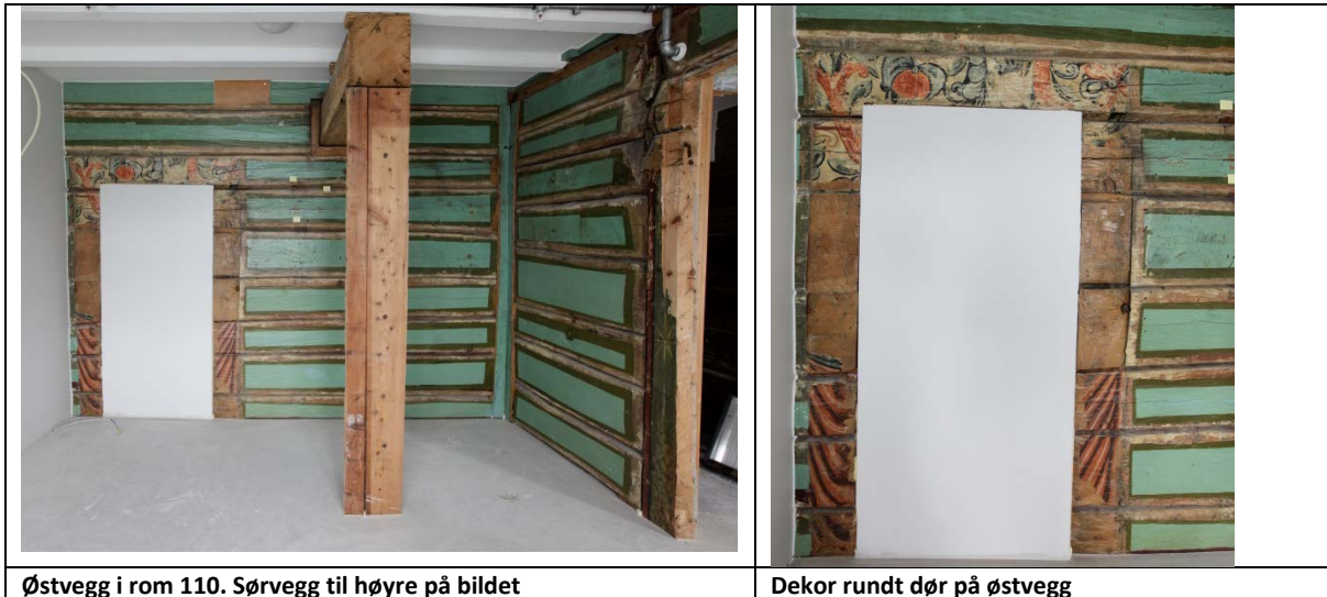
Østvegg i rom 110. Sørvegg til høyre på bildet
