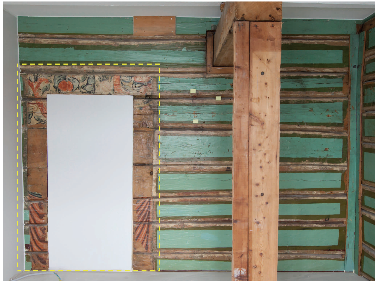
Vegg mot øst.
