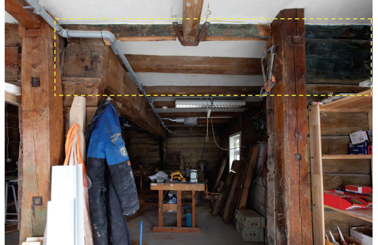
Vegg mot øst, søndre del, øvre veggdel.
