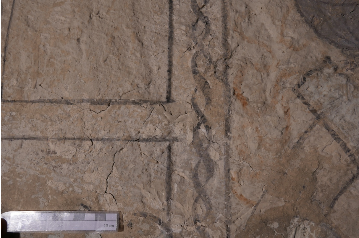
Figur 15: Detalj fra nordvegg. Sprekker i underlaget.
