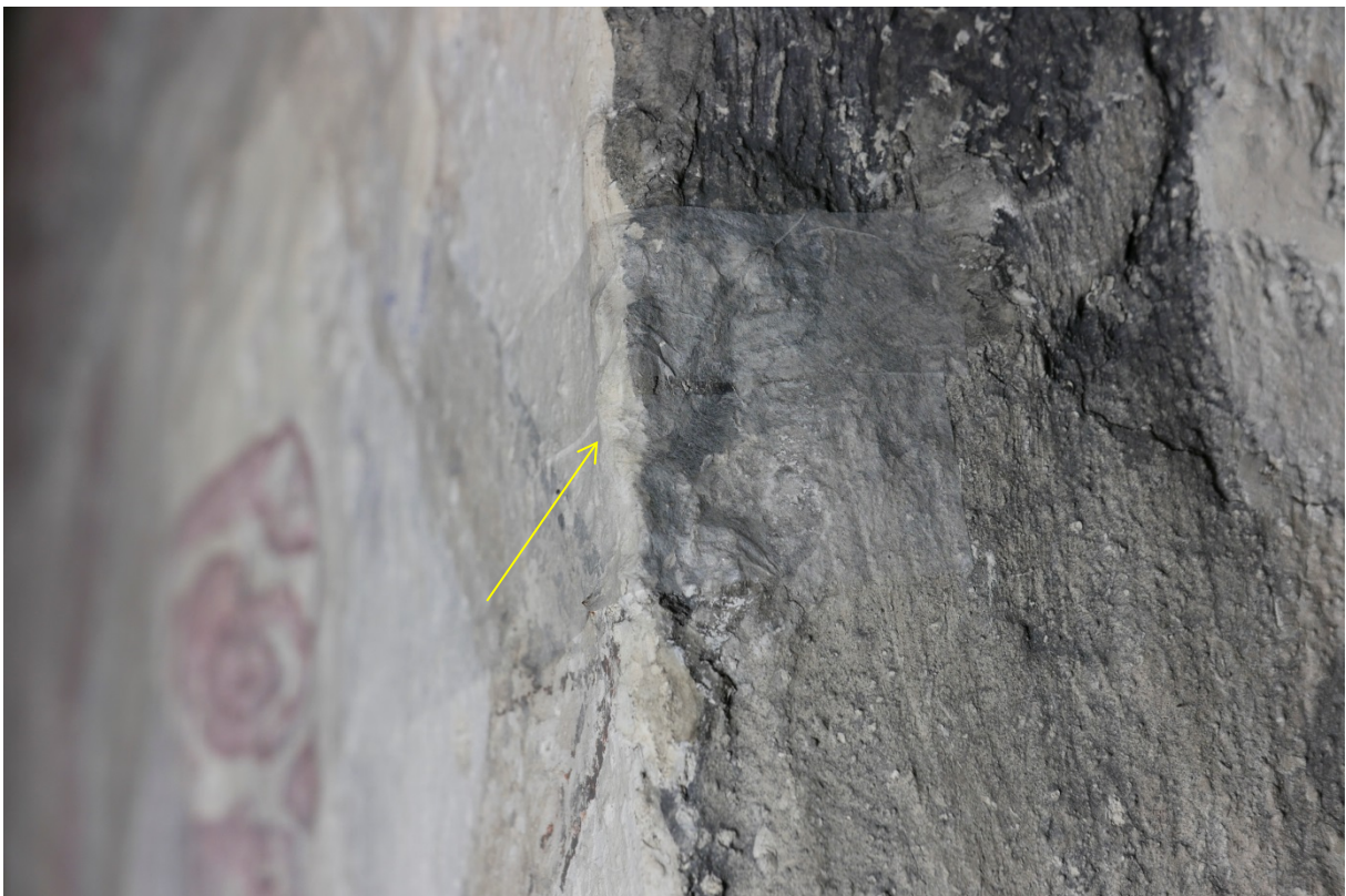
Figur 6: Detalj fra korbuen. En løs pussbit (trolig nyere mekanisk skade) har blitt nødsikret med japanpapir (pil).
