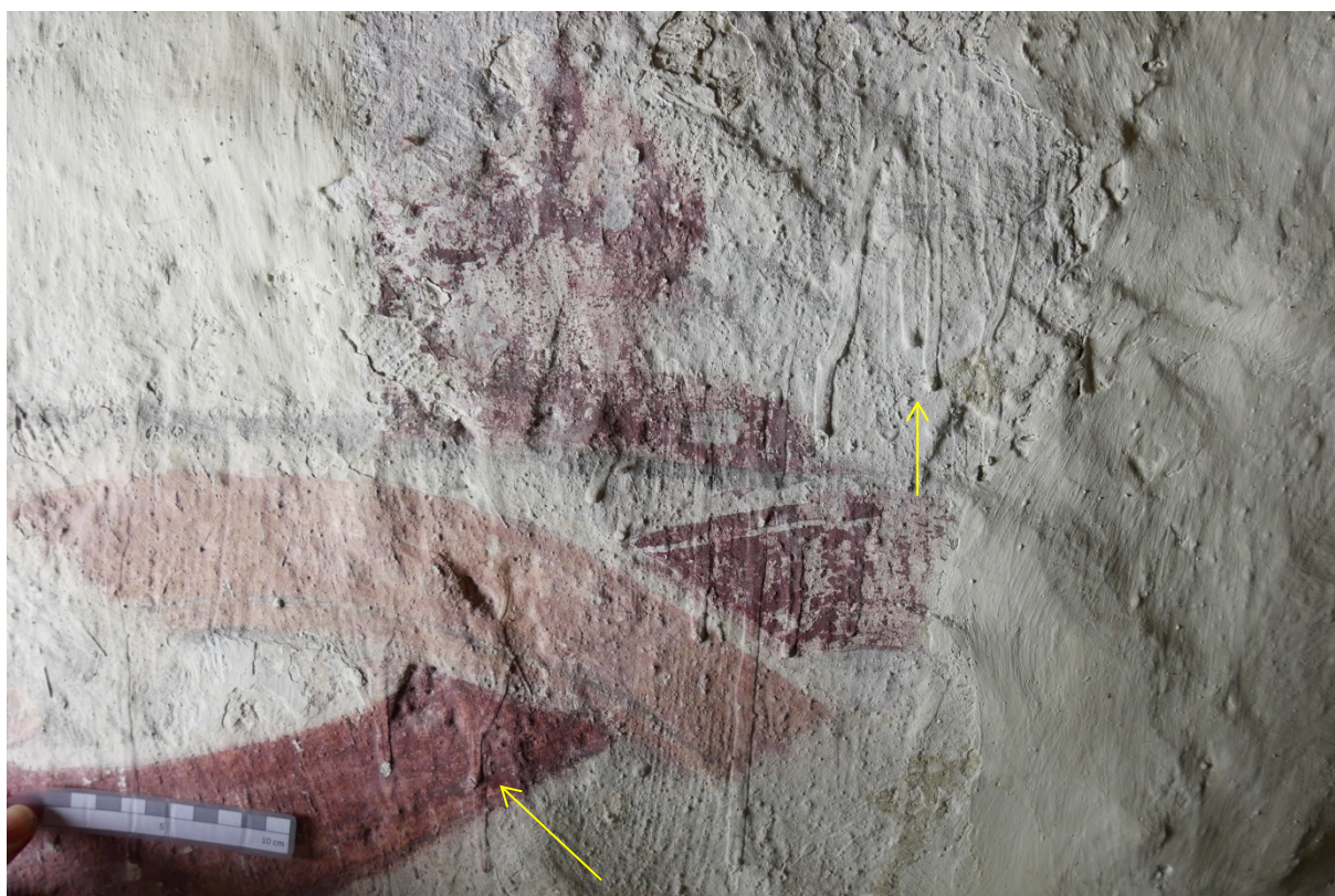
Figur 14: Detalj på sørvegg: slemmingen er grov påført og har tydelige penselstrøk og tykke rennespor (piler).
