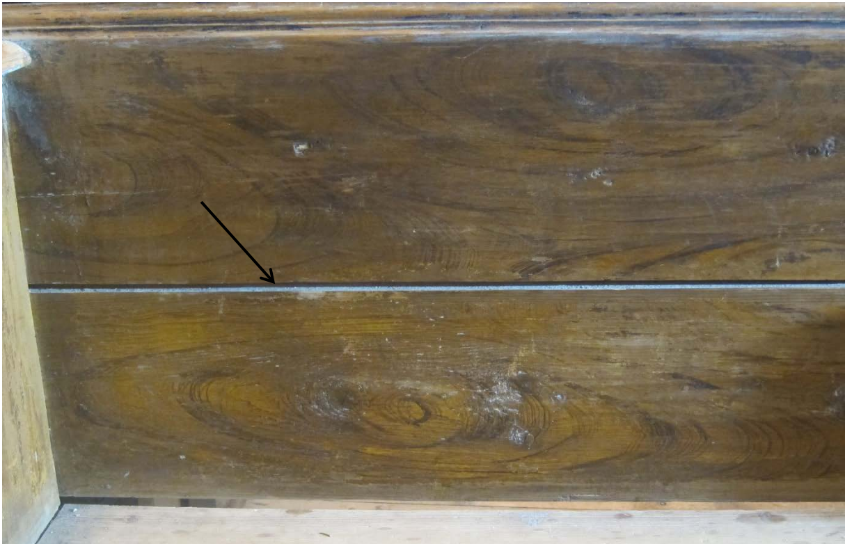
Figur 3 Benkens rygg med ådring. Sprekk mellom plankene på benkens rygg (svart pil).
