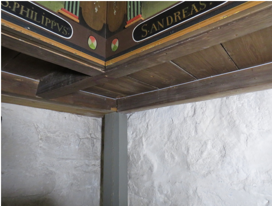
Figur 7 Eksempel på bærende konstruksjon under prekestolen
