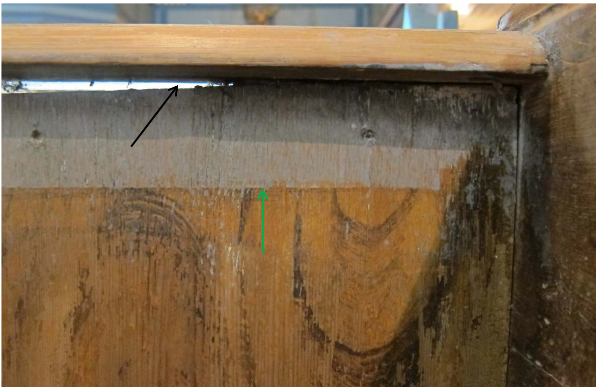
Figur 4 Høyre armlene er løst (svart pil). Under armlenet kunne det observeres rester av en tidligere overmaling (grønn pil).
