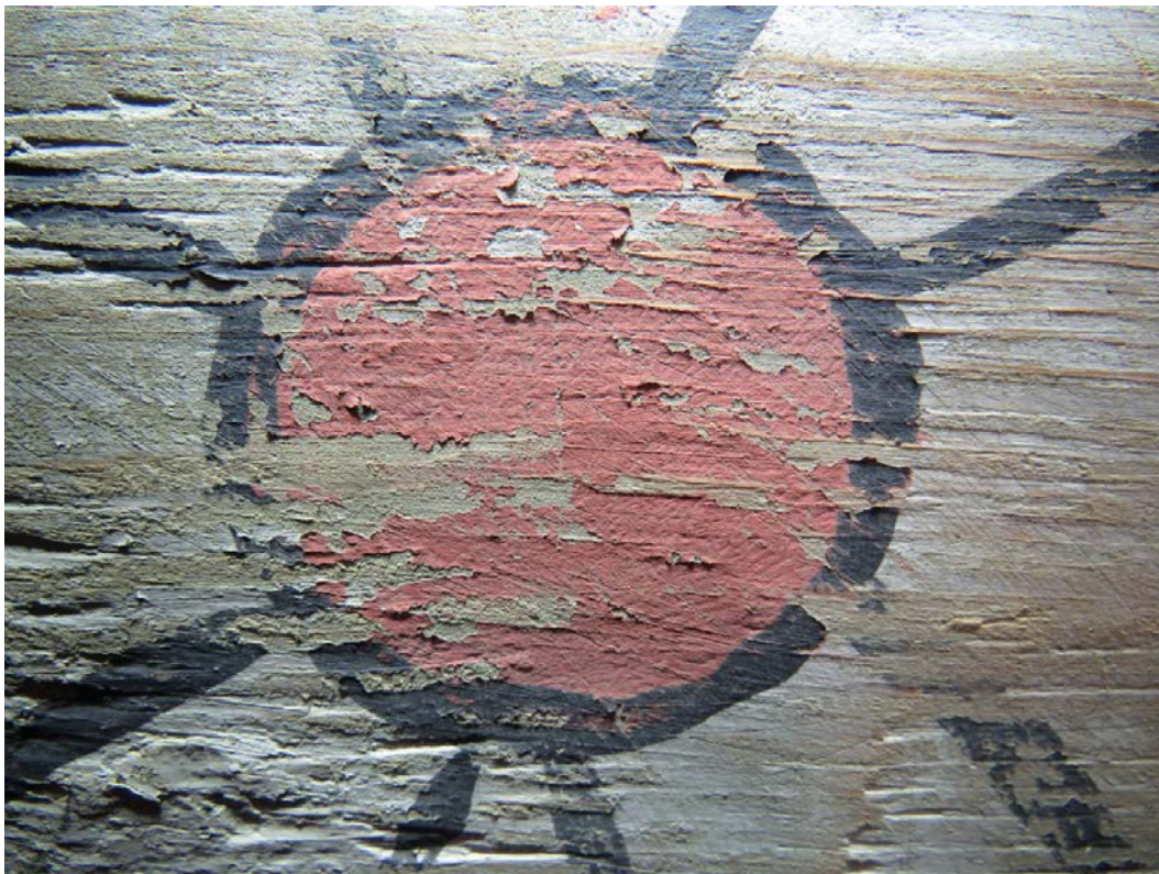
Figur 4 Felt 4, eksempel på løs maling på dekoren i himlingen
