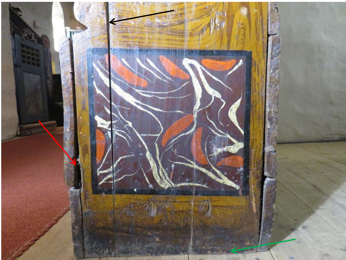
Figur 4 Detalj fra benkens venstre side. Sprekk mellom sammenføyningene på armlenet (svart pil), trebordet i front (venstre side i bildet) har slått seg og fått en konveks form (rød pil), slitasje på malingslag i nedre del (grønn pil).
