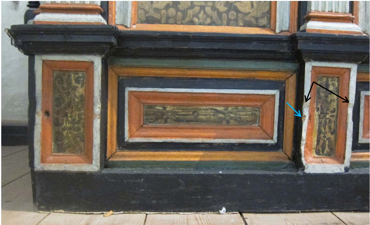
Fig. 5 Detalj av alterbordets front, nedre venstre hjørne. Mekaniske skader i treverket, delvis overmalt (svart pil), delvis av nyere dato (blå pil).
