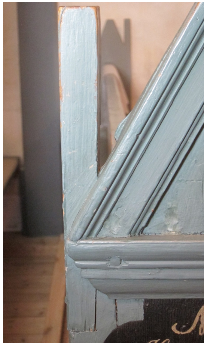
Fig 34 Detalj benkevange nr 14 nord. Spir er fornyet og festet med nagler.
