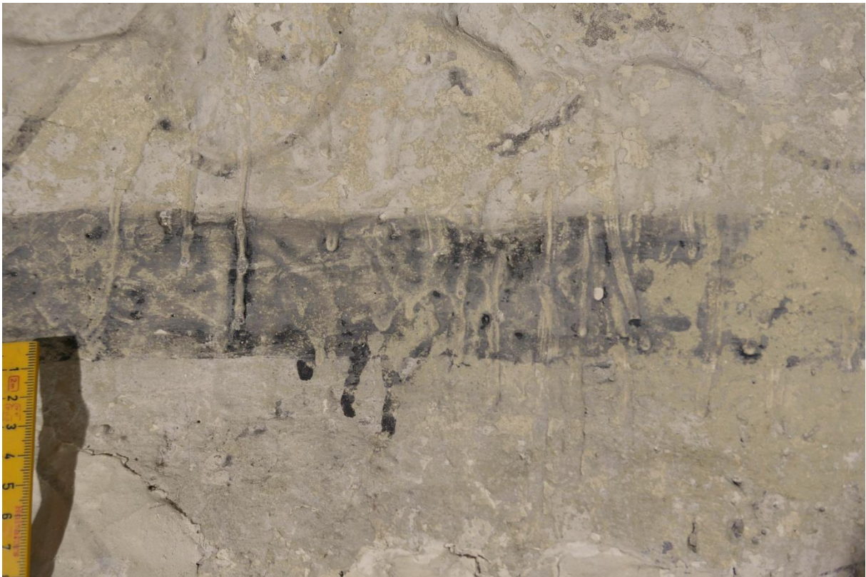
Figur 10: Detalj fra sørvegg. Tykke rennestriper både i slemmingslaget og i malingslaget.
