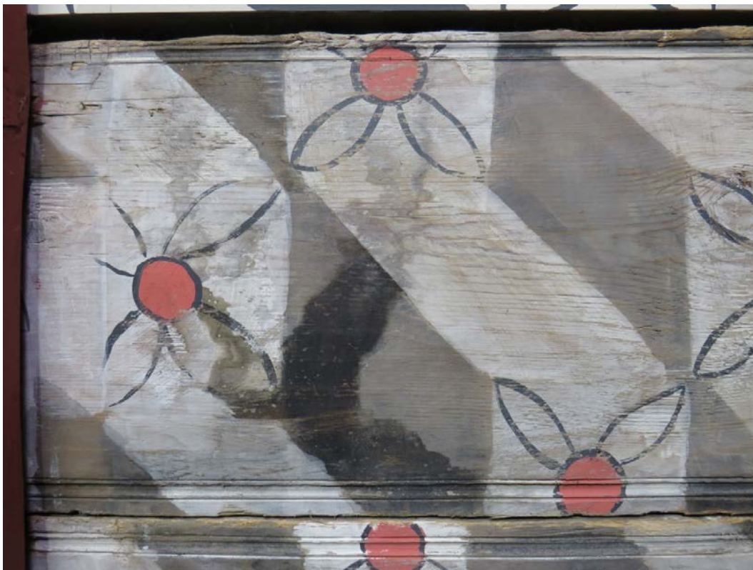
Figur 3 Felt 2, eksempel på fuktskade i himlingen
