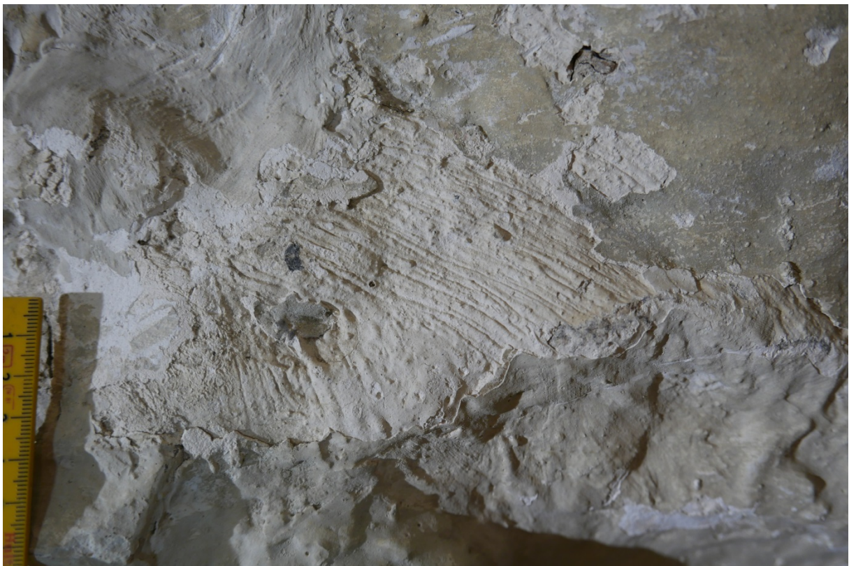
Figur 12: Detalj fra sørveggen. Større skade i slemmingslaget. I utfallet ser man et underliggende slemmingslag med grov penselstruktur.
