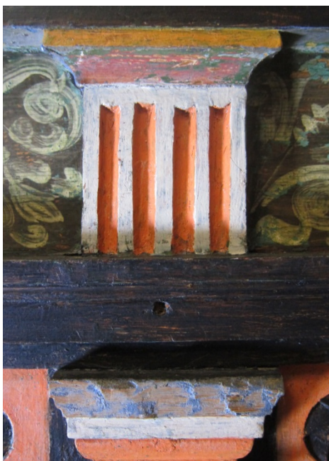
Fig. 10 Detalj søndre side av alterbord. Øverste profilerte avslutning på midtre pilaster. Kun rester av tidligere bemaling er bevart.
