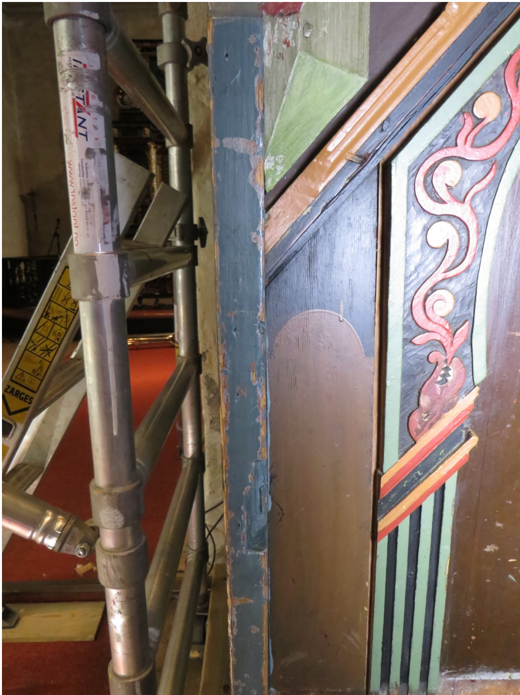
Figur 6 Eksempel på mekaniske skader på treverket, her ved inngang til prekestolen
