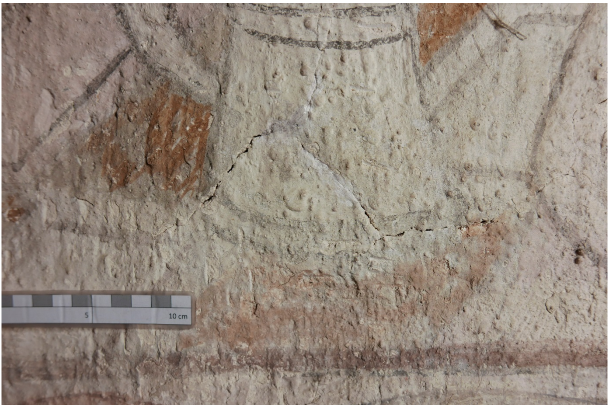
Figur 18: Detalj på sørvegg. Tynne sprekker i underlaget.
