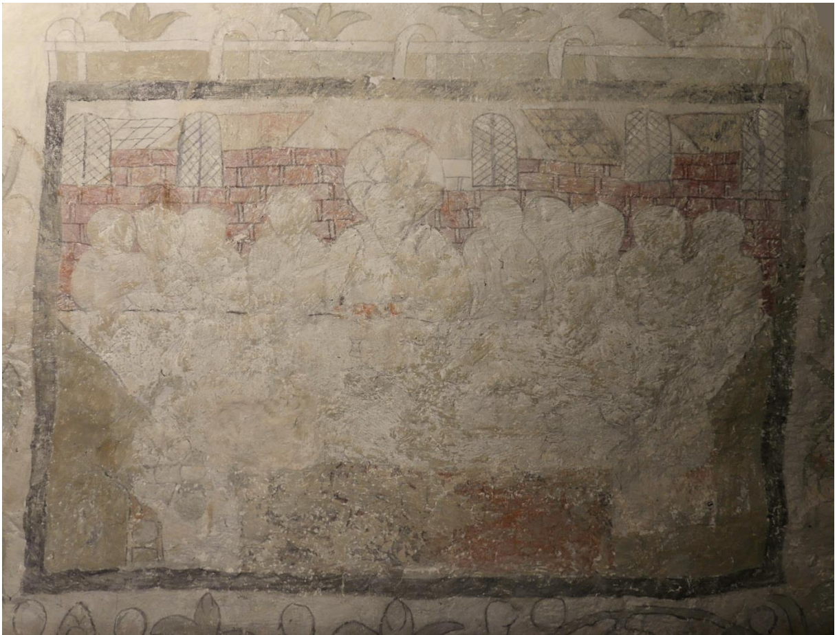
Figur 6: Bildescene på malt veggeng: «Nattverden». Nordveggen østre del bak galleriet.
