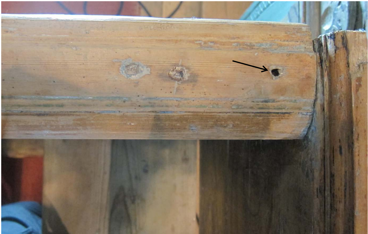
Figur 5 Venstre armlene sett ovenfra. Bildet viser et av to steder der det mangler en plugg (svart pil).
