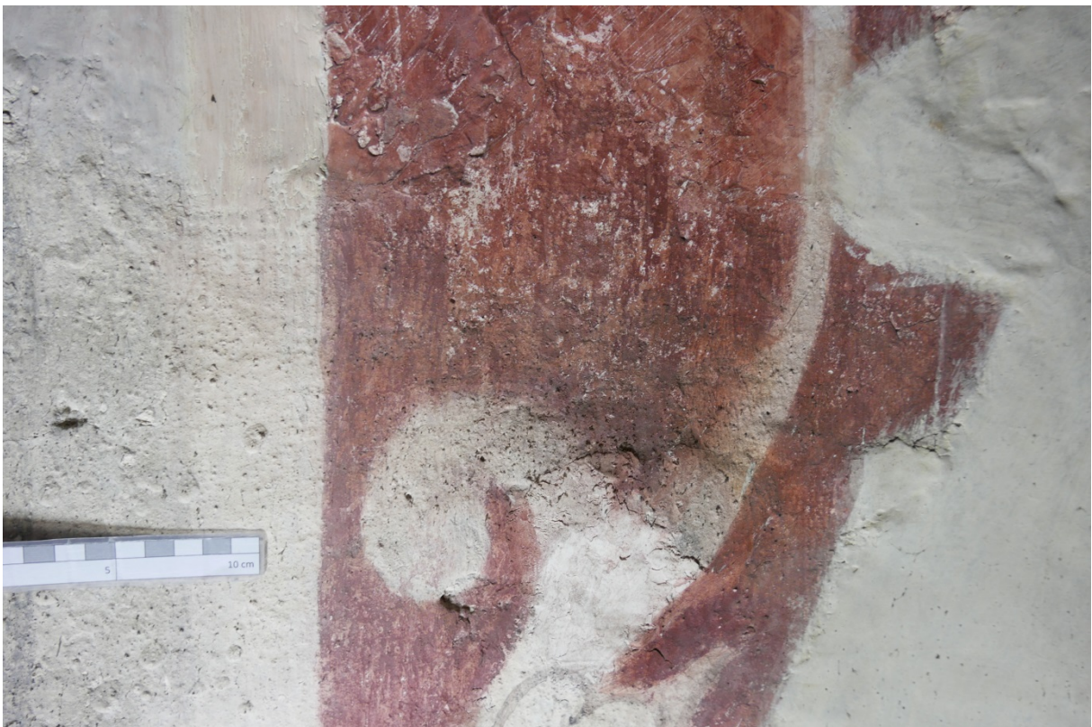
Figur 24: Detalj på sørveggen. Veggoverflaten er skitten og støvete.
