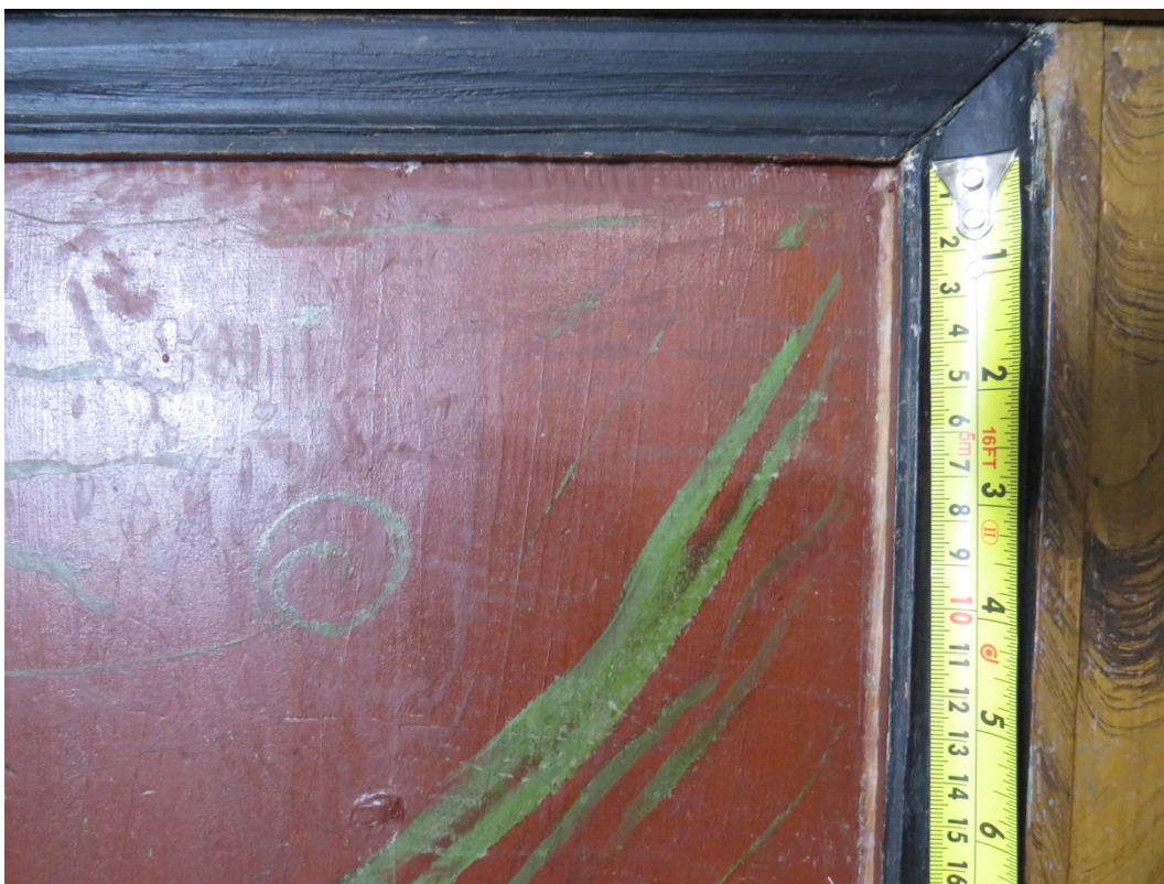
Figur 6 Detaljbilde som viser forskyvning av en av fyllingene i klokkerbenken
