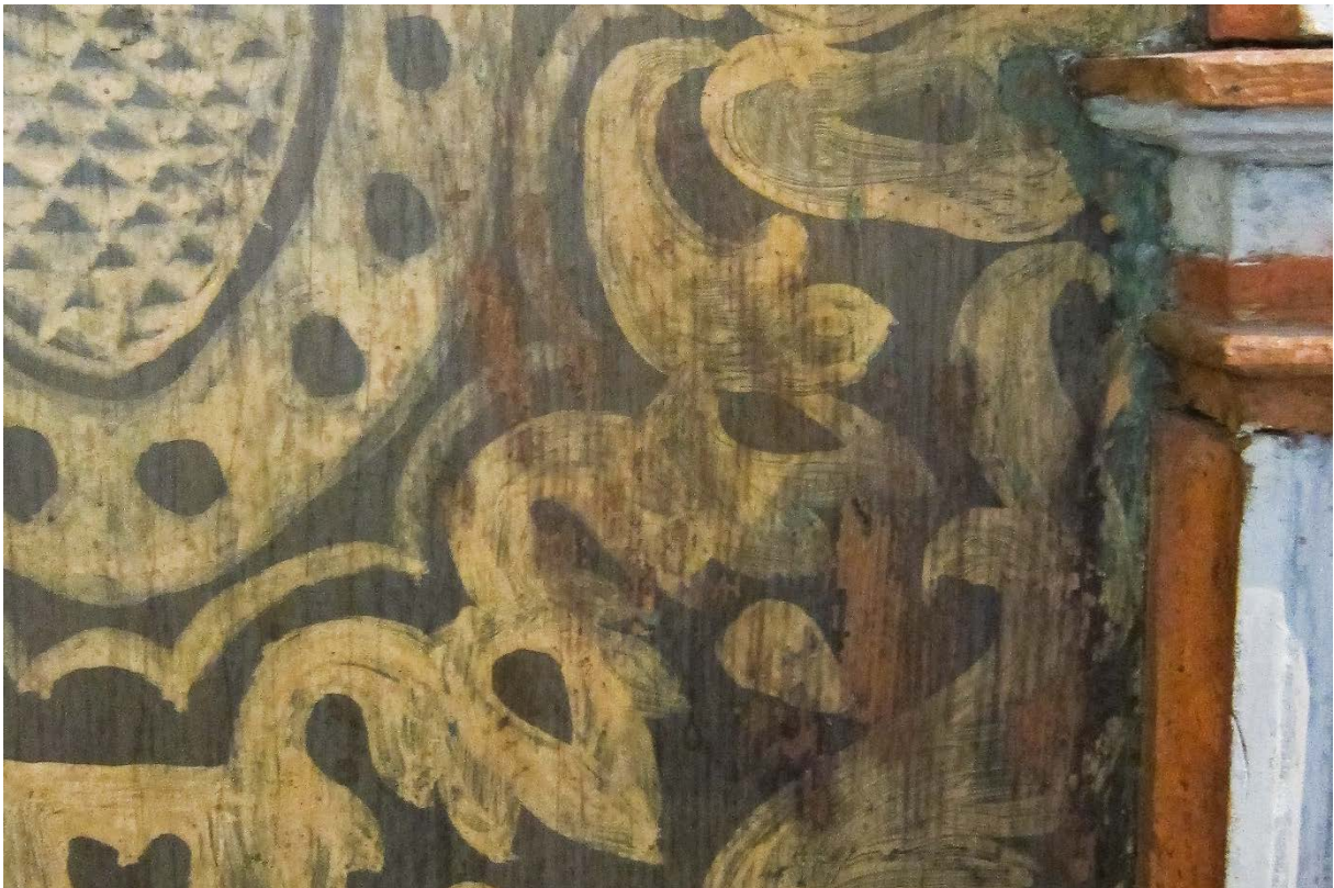
Fig. 8 Detalj av front, alterbord. Slitt maling i fylling nr. 1 fra venstre.
