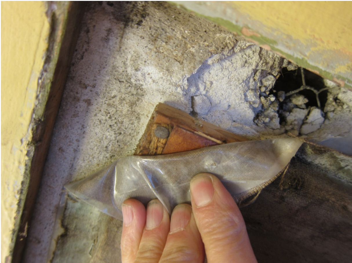
Figur 8. Demontering av pynterammeliste på maleri nr. 4 viste at det bemalte lerretet er spent opp på en plate satt sammen av stående rupanel. Platen er dekket av strie og dekkeplast.
