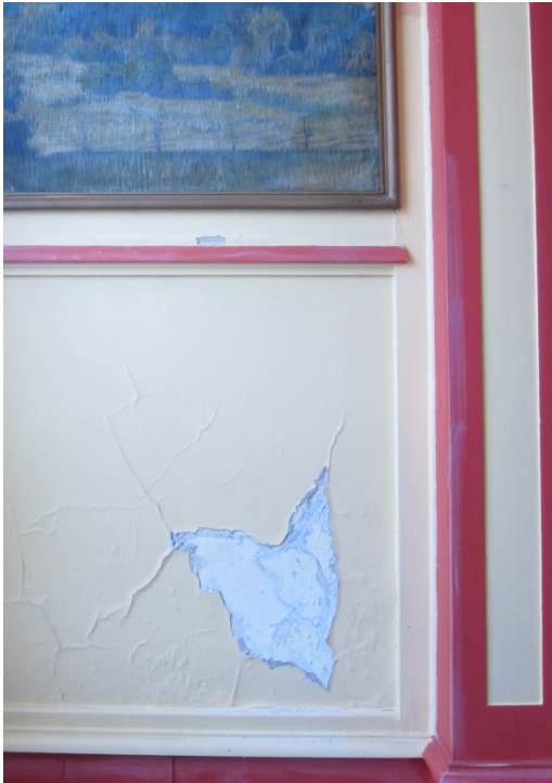
Figur 10. Saltutslag på murvegg mot vest.
