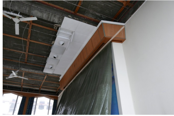
Figur 5: Over veggmaleriet er det montert en trekasse. Foto: NIKU 2017
