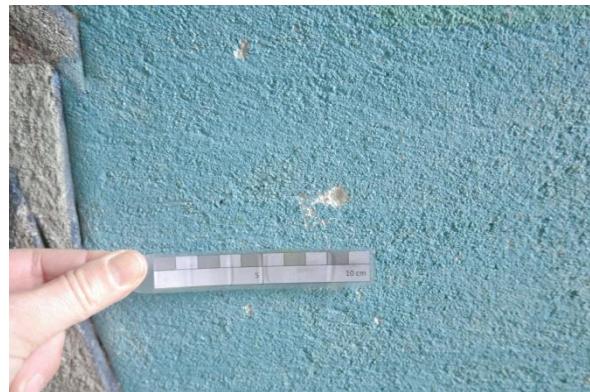
Figur 11: Detalj fra veggmaleriet. Hakk med fordypning i pussen. Foto: NIKU 2017
