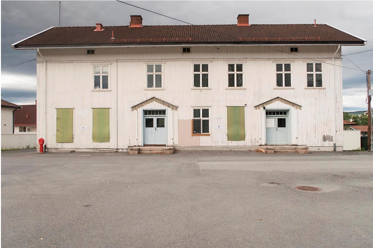
Bygning - Tingstua-Hokksund-N Kilde: NIKU 2018
