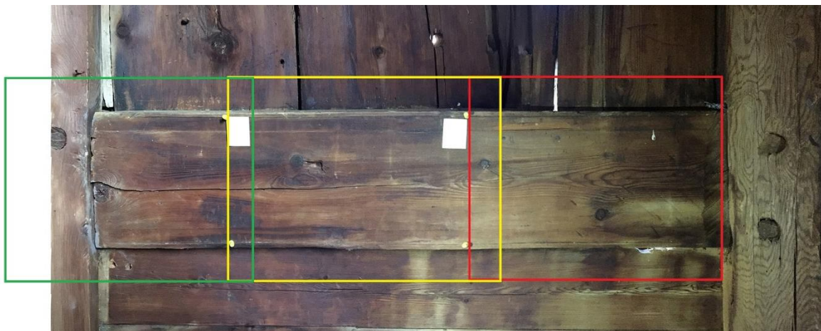
Figur 5. Firkantene markerer røntgenfilmens plassering på midtromssvilla inne i kirken. Hjørnestav mot sørvest på høyre kant i bildet; en av fire mellomstaver på sørsiden ses på venstre kant i bildet. Foto: NIKU
