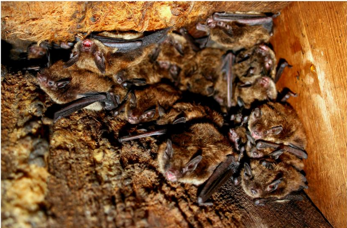
Figur 16. Foto av flaggermus i trekonstruksjon. I nedre del av bildet vises klumpete forsteininger som dannes av urin og avføring fra flaggermus. Øverst til venstre i bildet: svært flusset treoverflate. Viser dette nedbrytning av treverk som kan skyldes flaggermus-urin? Hentet fra nettside https://www.mass.gov/news/study-on-little-brown-bats-continues .
