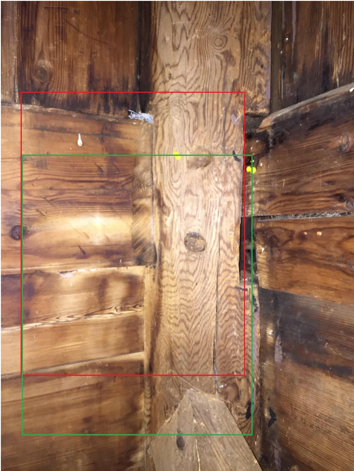
Figur 10. SV stav med inntappede midtromssviller. Firkantene markerer røntgenfilmens plassering på staven, rød svarer til figur 12, grønn til figur 13 (de gule prikkene er NIKUs tegnestifter, brukt til å feste røntgenfilmen til veggen.) Foto: NIKU
