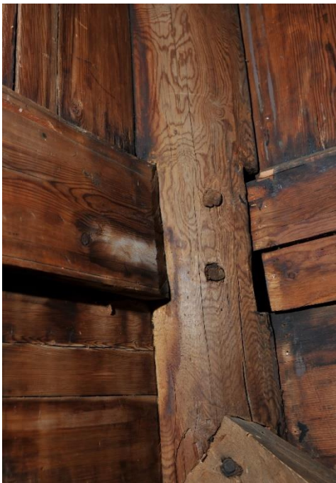
Figur 1. Sørvestre hjørnestav ses midt i bildet, søndre midtromssvill ses til venstre i bildet. Foto: Riksantikvaren.
