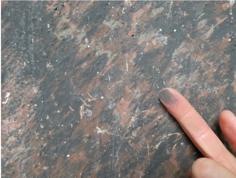
Figur 13 Malingen smitter av ved berøring.
