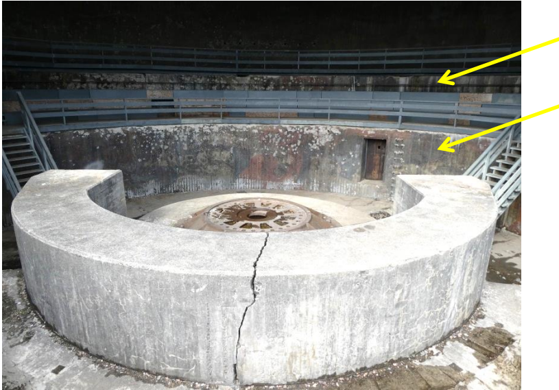
Figur 2 Malte vegger i kamuflasjemønster inni kasematten; på gulvnivå og «tribunenivå».
