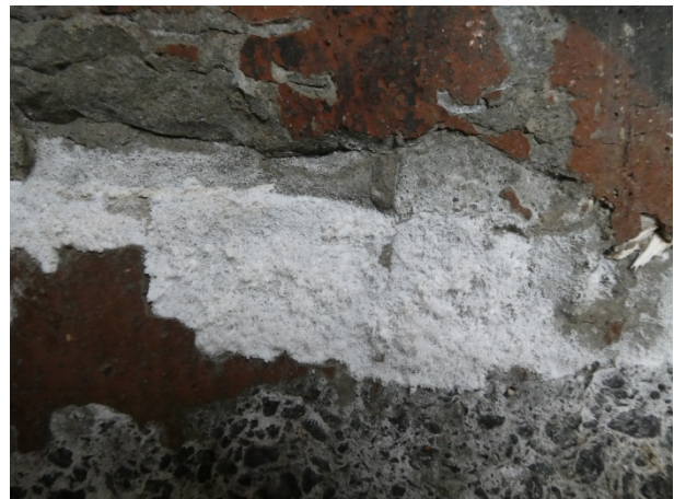
Figur 4 Saltutslag i nedre del.
