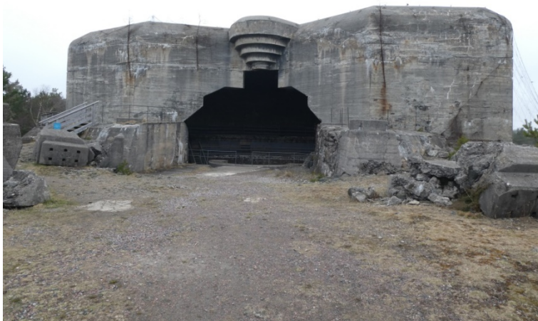
Figur 1 Kasematten på Møvik fort.
