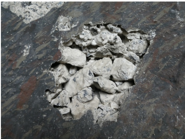
Figur 3 Grovt tilslag i sementen.
