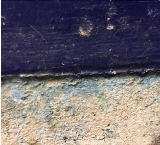
Fig. 3 Undermaling synlig langs nedre kant av maleri i 2. etasje
