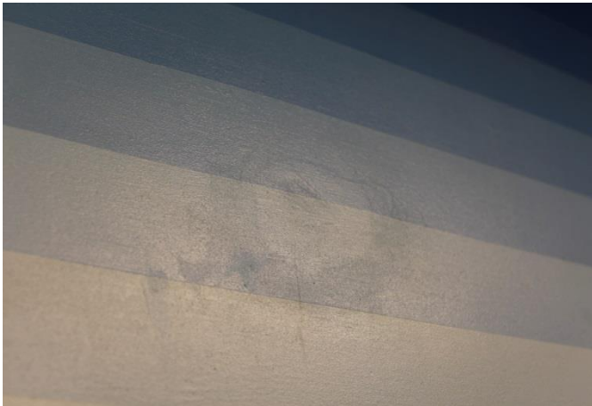
Fig. 5 Pussreparasjoner på vegg utført før Kleiva malte
