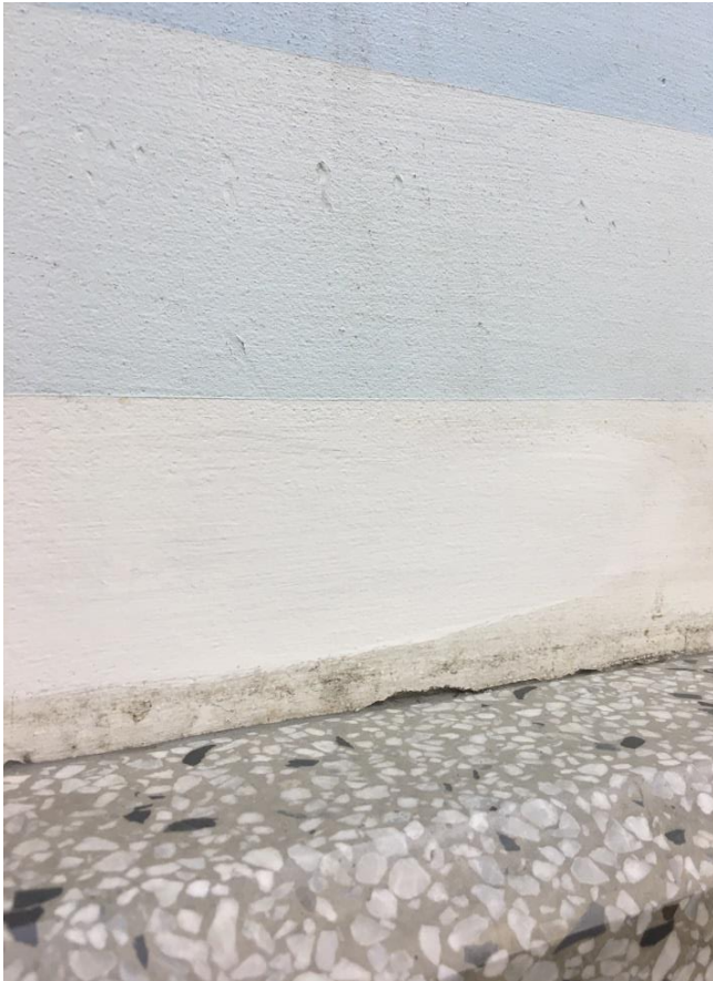
Fig. 19 1. etg: overgang mellom terrasso og maleri
