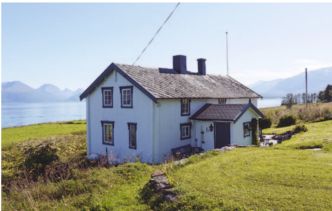
FIGUR 2. Att klä ytterväggarna med panel är inte bara en fråga om dräkt och stilideal. Det bidrar också till att förbättra inomhuskomforten och skydda den annars blottade timmerstommen från det barska klimatet längs Norges kuster. Klimatanpassning är på så sätt sedan länge ett nedfällt koncept i byggnadstraditionen. FOTO: NIKU.
