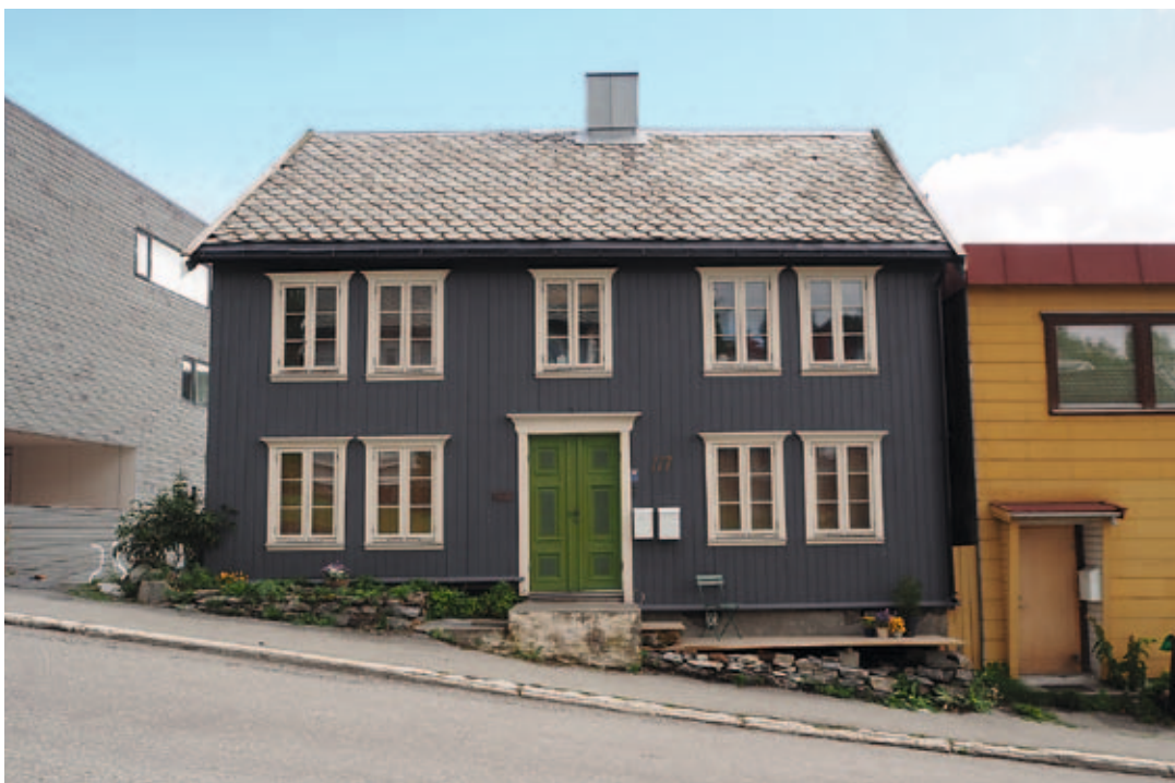
FIGUR 1. Ett bostadshus från 1853 i Tromsø som energieffektiviserats och genomgått en förhållandevis varsam restaurering. Granntomten med äldre bebyggelse fick ge vika för nya energieffektiva lägenheter. FOTO: NIKU.
