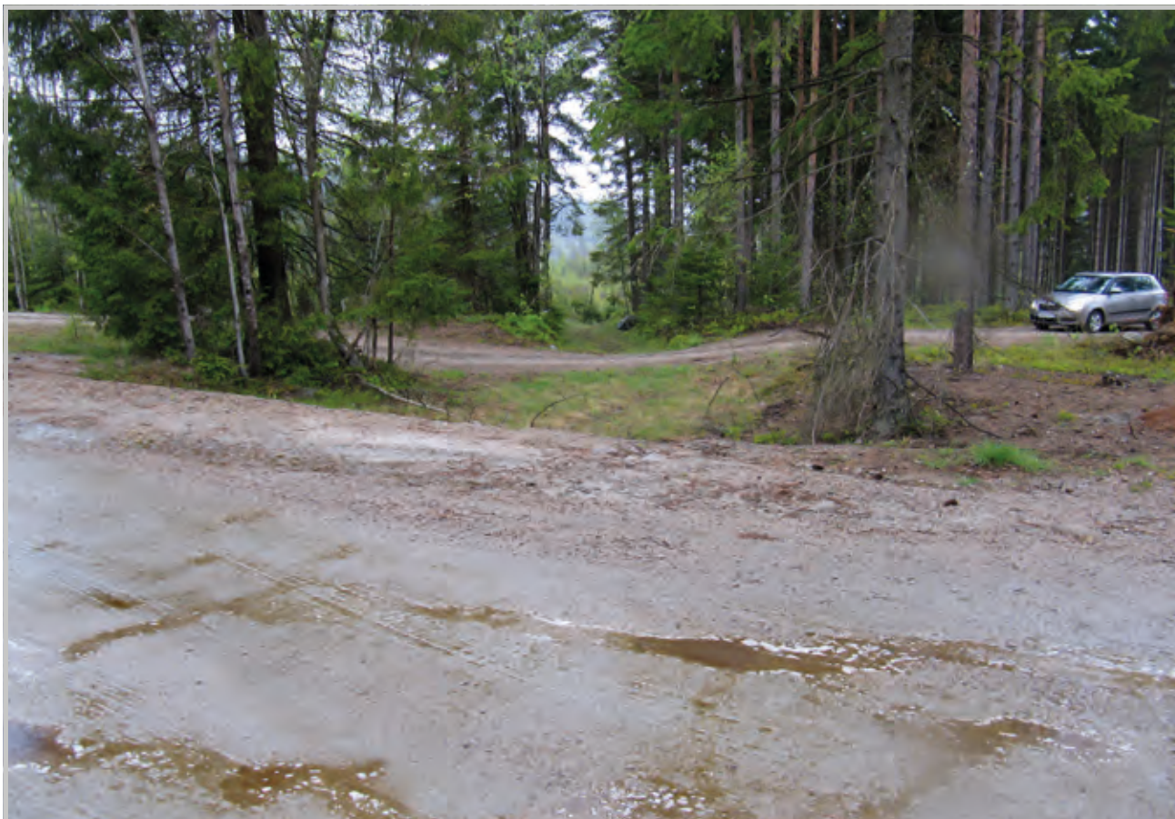
Figur 20. Hulveien, id 49246 som nå blir krysset av to veier Den nyeste er en treningsvei for hestekjøring, mens den eldste bilveien er utbedret på bekostning av hulveien. Foto: NIKU 2014.
