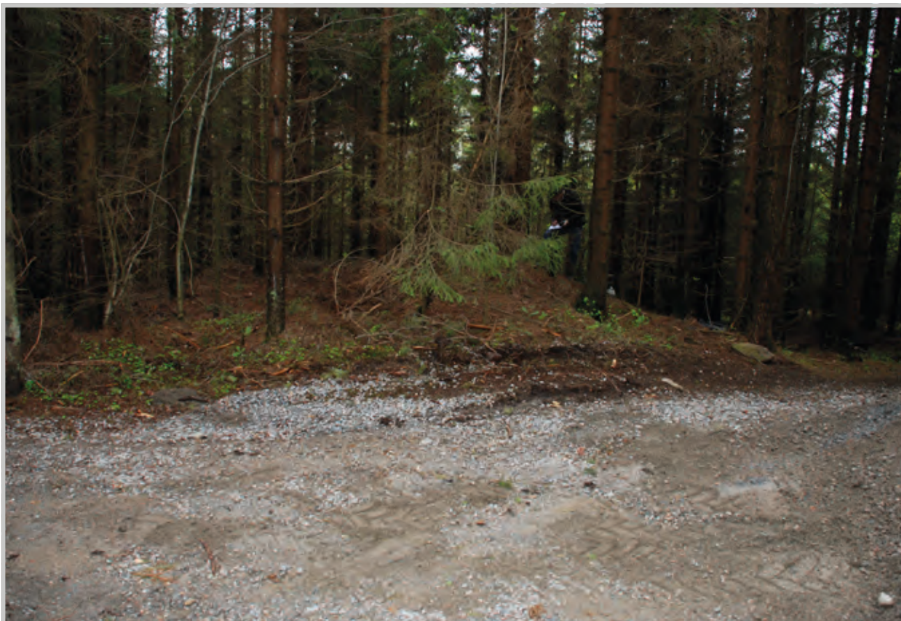
Figur 21. Gravhaugen, id 30691-10, på Rønnild er skadet ved veiutvidelse. Foto: NIKU 2014.
