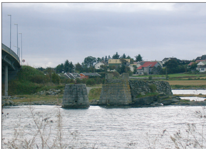
Figur 18: Brukar fra Hafrsfjordbroen over til Sola som ble oppført i 1925. Ved siden av er dagens bro fra 1966. Foto NIKU.
